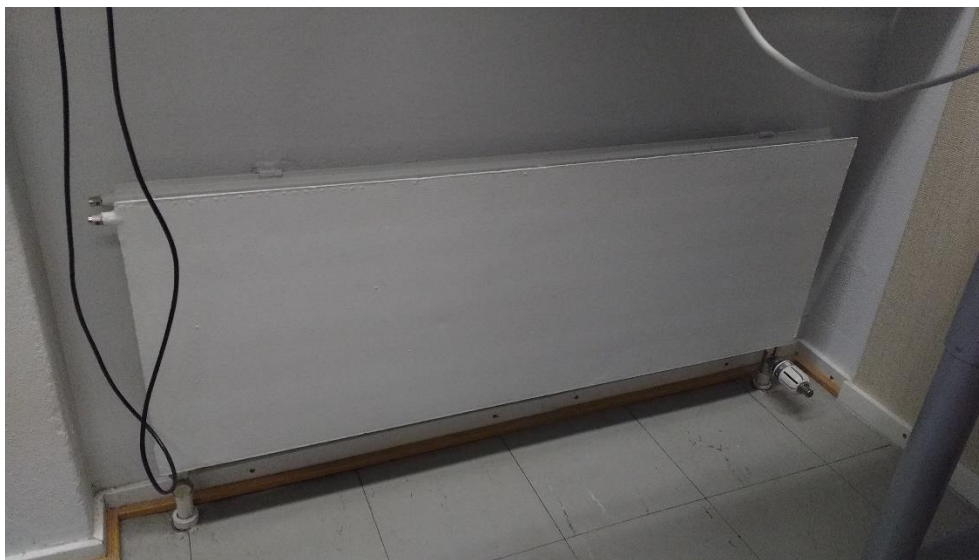
Kuva 10. Epätasaisesti lämpenevä patteri
