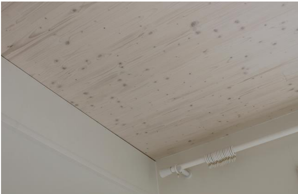
Kuva 4. Sisäkatoissa on näkyvissä CLT (Sanjanen 2016).
