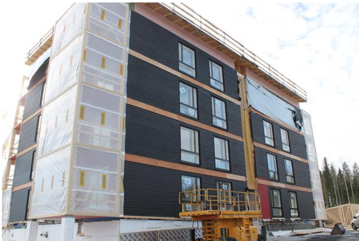
Kuva 3. Elementtien suojat poistetaan vasta kun elementit ovat paikoillaan (Sanjanen 2016).
