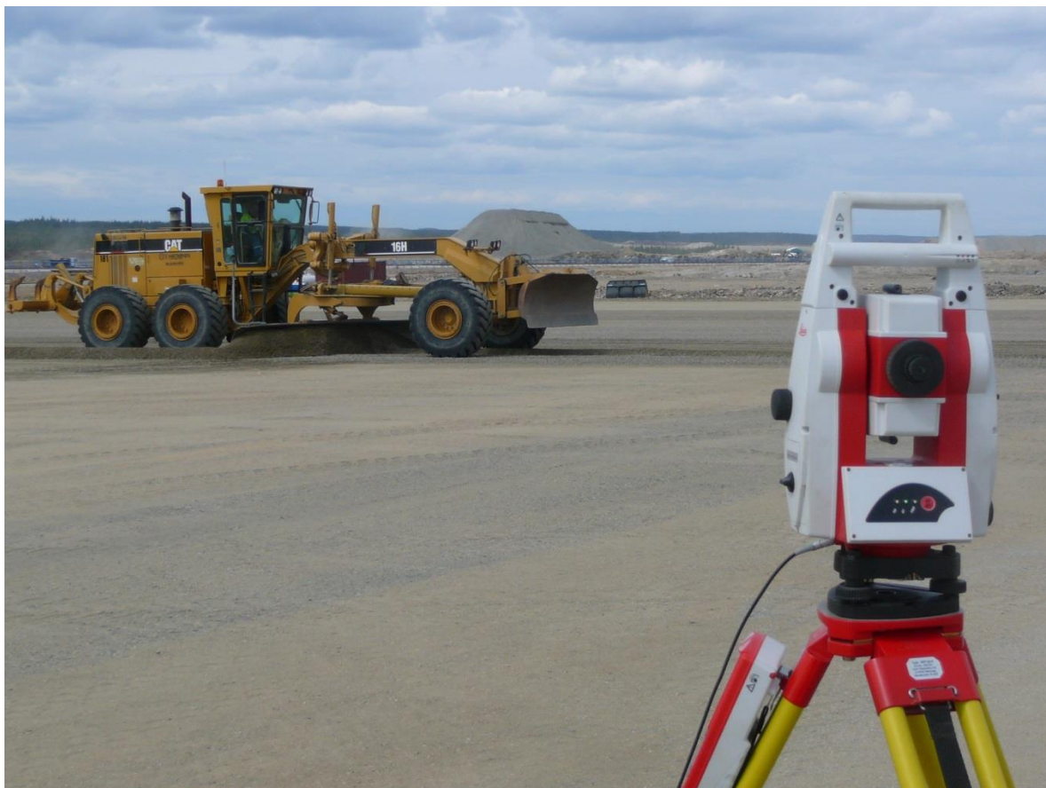
Kuva 11. Takymetriohjattu tiehöylä (Hannuksela 2008)
