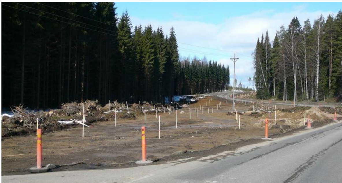
Kuva 30. Perinteisellä mallilla suoritettu tielinjan maastoonmerkintä (Hannuksela 2013)
