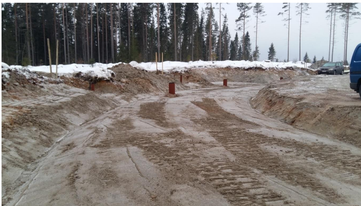
Kuva 31. Altekin koneohjattu katurakennuskohde Jyväskylän Palokassa. Katualueen reunoilla ei ole ainuttakaan mittapaalua. Kuvassa näkyvät lankut on pystytetty tonttihaaroihin merkitsemään vesijohtojen ja jätevesiviemärien päiden sijaintia. (Hannuksela 2017)
