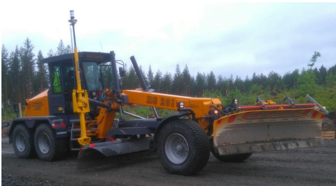
Kuva 16. Matti Saarinen Oy:n takymetriohjattu tiehöylä Altekin työmaalla Jyväskylän Palokassa. Pääterään on kiinnitetty aktiiviprisma, jota robottitakymetri seuraa. (Saarinen 2016)
