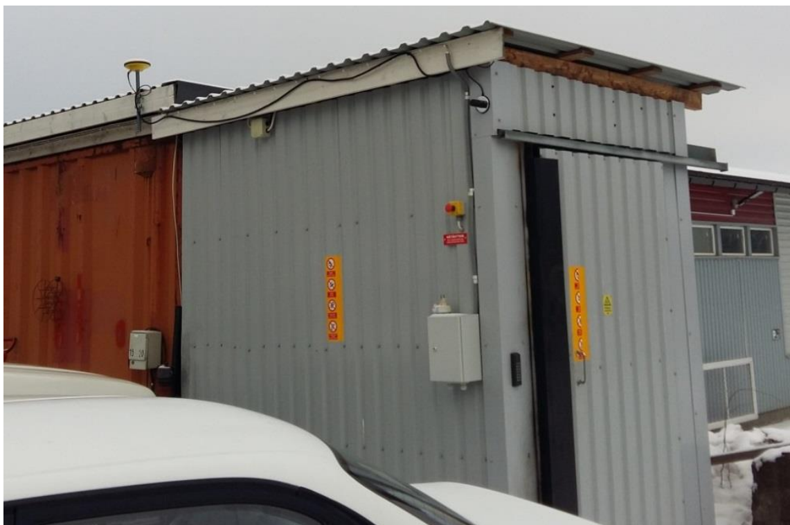
Kuva 8. Maansiirto Harry Mäkelä Oy:n kiinteä tukiasema. Tukiasema lähettää korjausdatan työkooneille internetin välityksellä, tarjoten korjauspalvelun n. 20 - 30 km:n säteelle. Korjausdatan välityksessä internetin avulla, poistuvat esimerkiksi maaston muodosta aiheutuvat häiriöt korjausdatan välittämisessä. (Hannuksela 2017).
