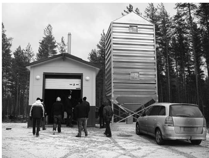
Kuva 2. Keuruun lämpövoima Oy:n pellettilämpökontti Haapamäellä.
