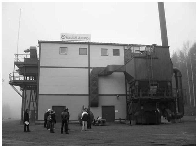
Kuva 3. Saarijärven Kaukolämpö Oy:n uusi 4 MW:n lämpövoimalaitos Sara-aholla.
