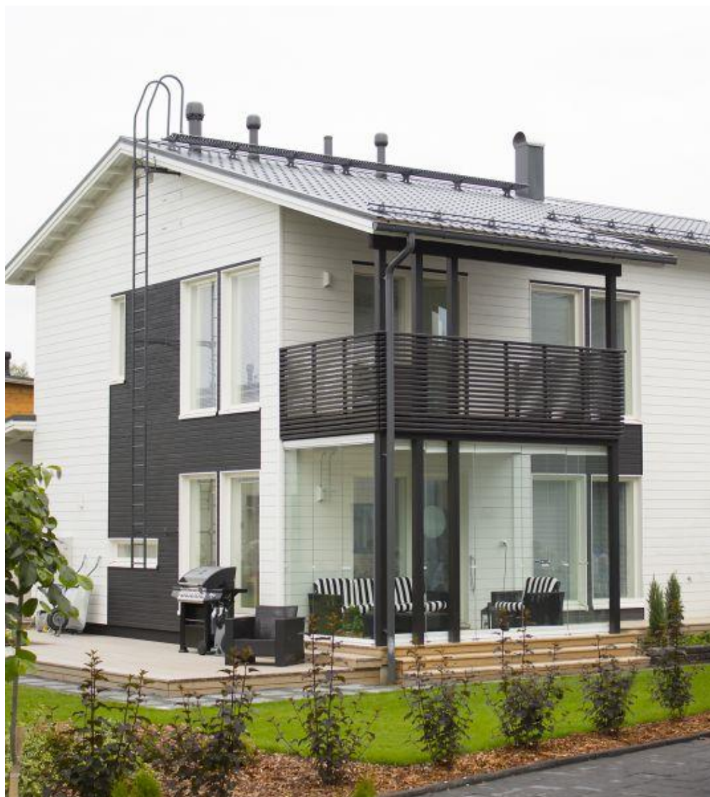
KUVA 2. Kattoturva- ja sadevesijärjestelmä asuntomessuilla 2015 (Orima-Tuote Oy 2017a)
