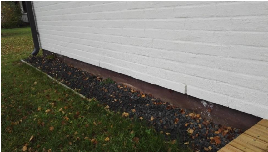
Kuvio 4. Kohteen perusmuurin ulkopinta
