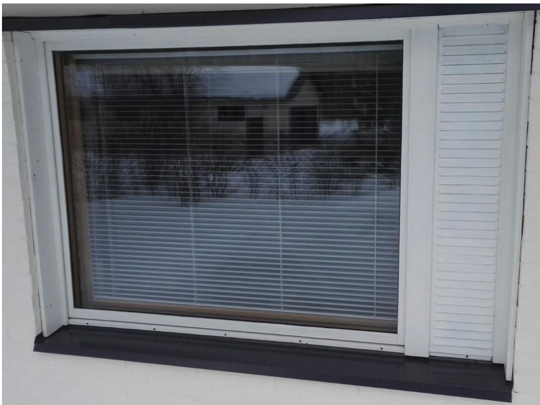
Kuvio 8. Ikkuna ja ikkunapelti
