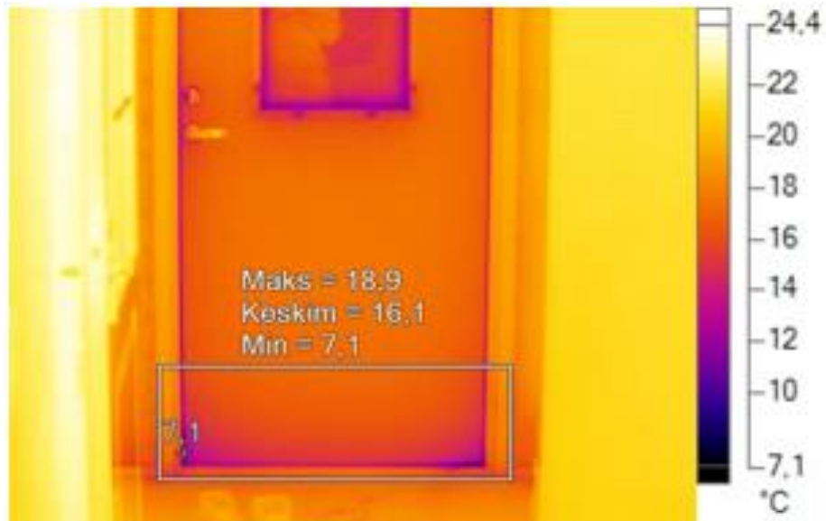
Kuvio 18. Pääsisäänkäynnin ovi
