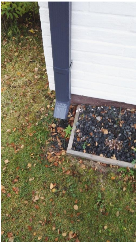
Kuvio 6. Puutteellinen sadevesijärjestelmä
