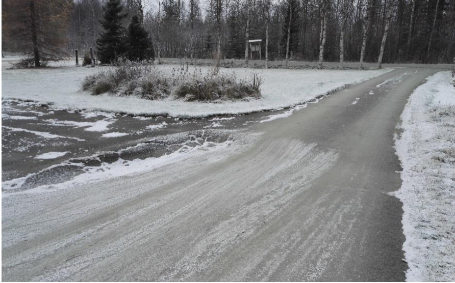
Kuvio 2. Asfaltoidun pihatien routavaurio
