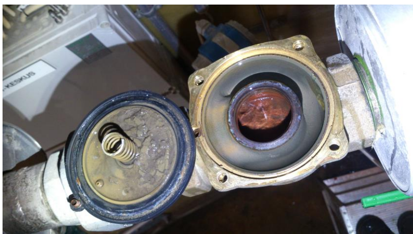
Figur 17 Säkerhetsvattnets solenoid venti och dess smutsiga membran (Sirai L280)
