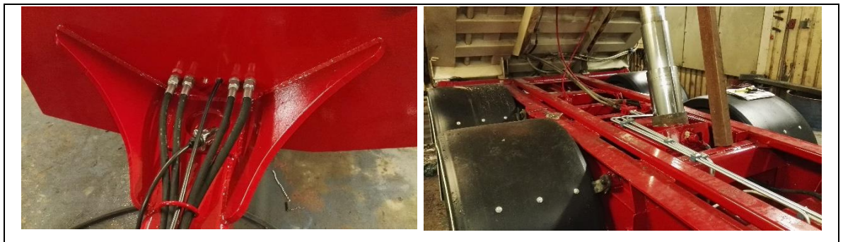
Kuva 44. Hydrauliiikka ja putkitukset
