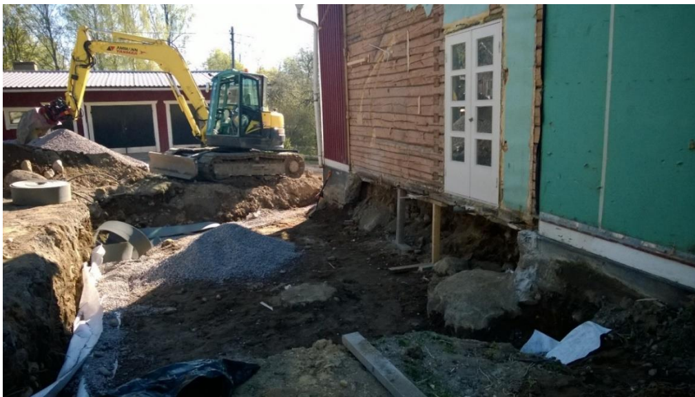
Bild 6 Grävande som skedde för att kunna gjuta nya plinten och sockeln (Foto: Johanna Nummelin)
