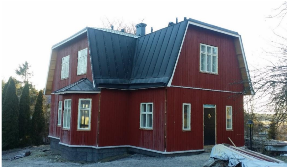
Bild 11 Holmströmska huset från december 2016 då isoleringen redan var satt och utsidan av huset börjar få sin form. (Foto: Tea Heimbürger)
