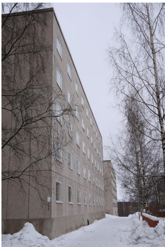
KUVA 6. Pesubetonielementtjulkisivu (Komulainen 2017)
