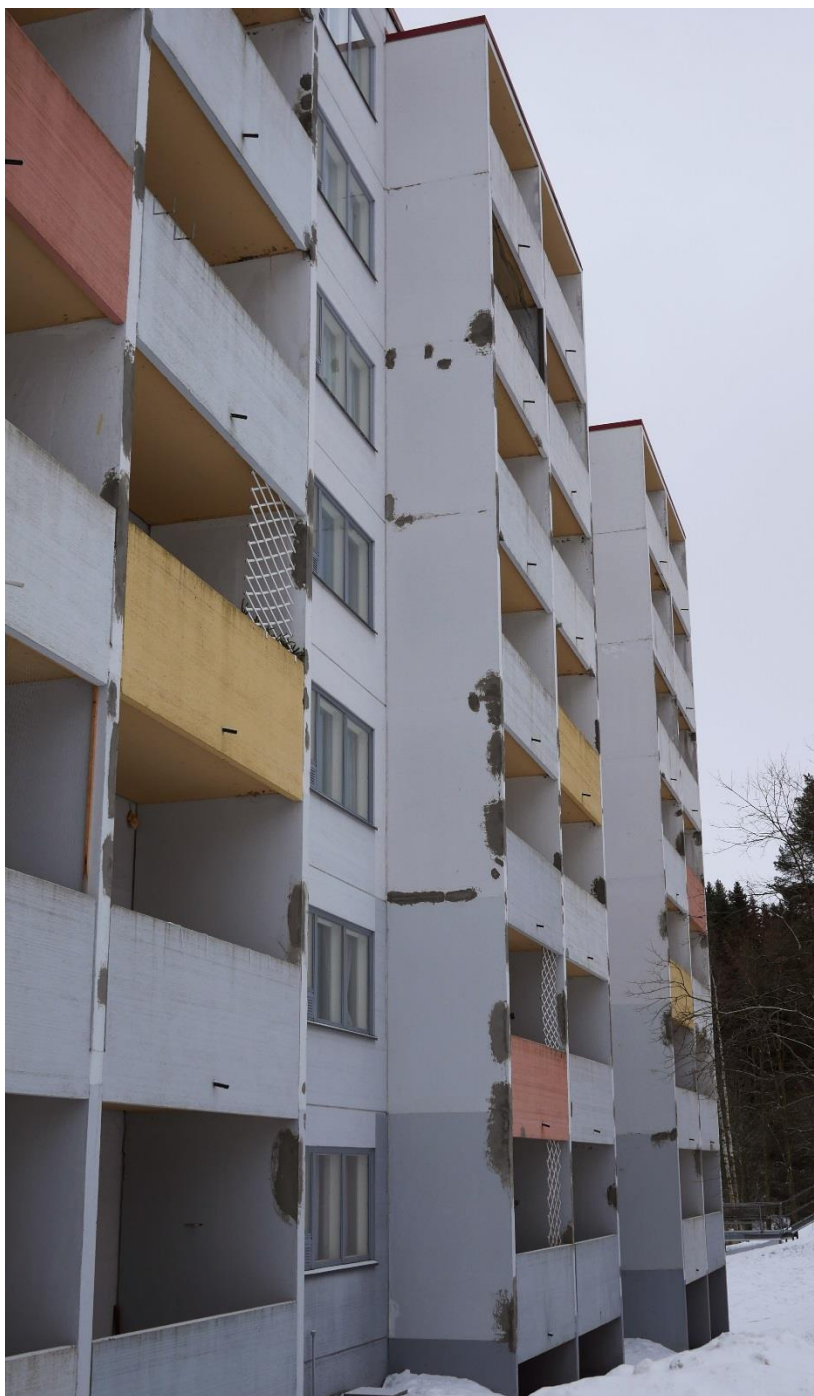
KUVA 9. Paikattuja rapautumia parvekkeissa (Komulainen 2017)
