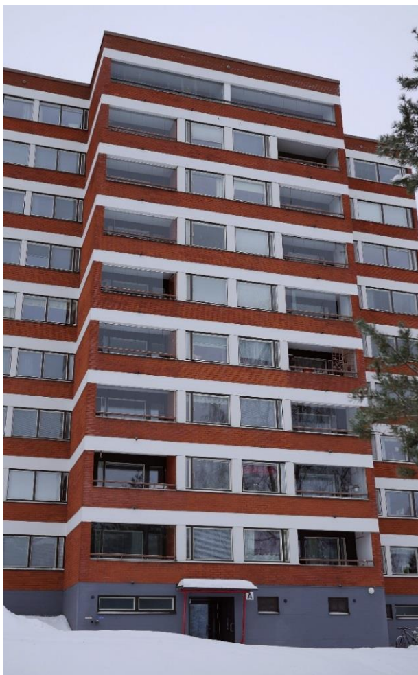
KUVA 11. Upotettuja parvekkeita (Komulainen 2017)
