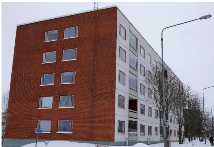
KUVA 7. Elementti- ja tiiliverhouksen yhdistelmä (Komulainen 2017)
