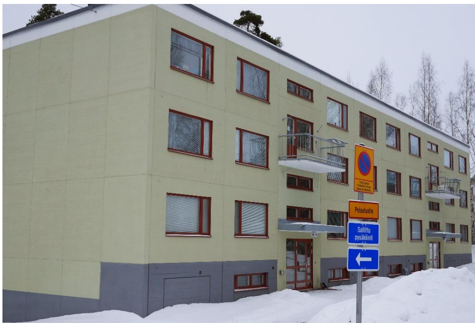
KUVA 5. Maalattu betonielementtjulkisivu (Komulainen 2017)
