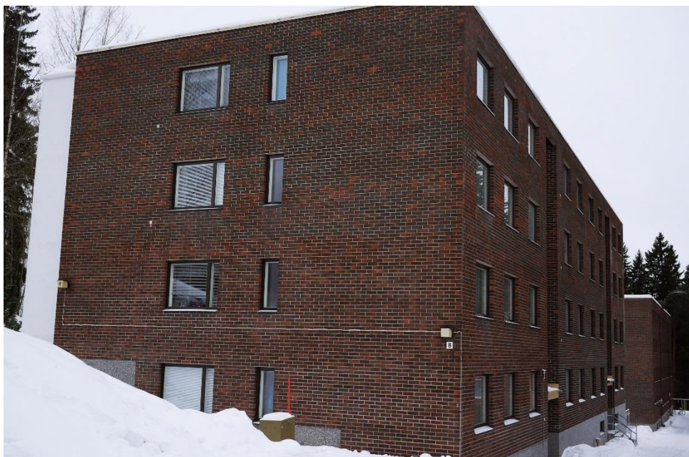
KUVA 8. Tiiliverhottu julkisivu Saarijärvellä (Komulainen 2017)
