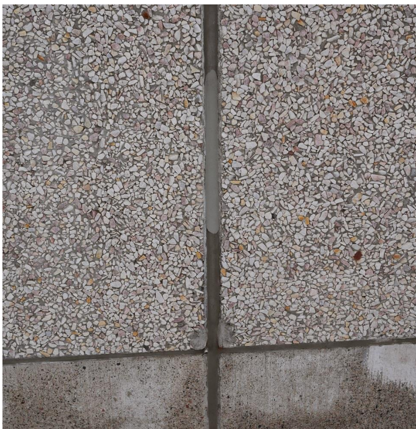
KUVA 14. Paikkaamalla korjattua elementtisaumausta (Komulainen 2017)
