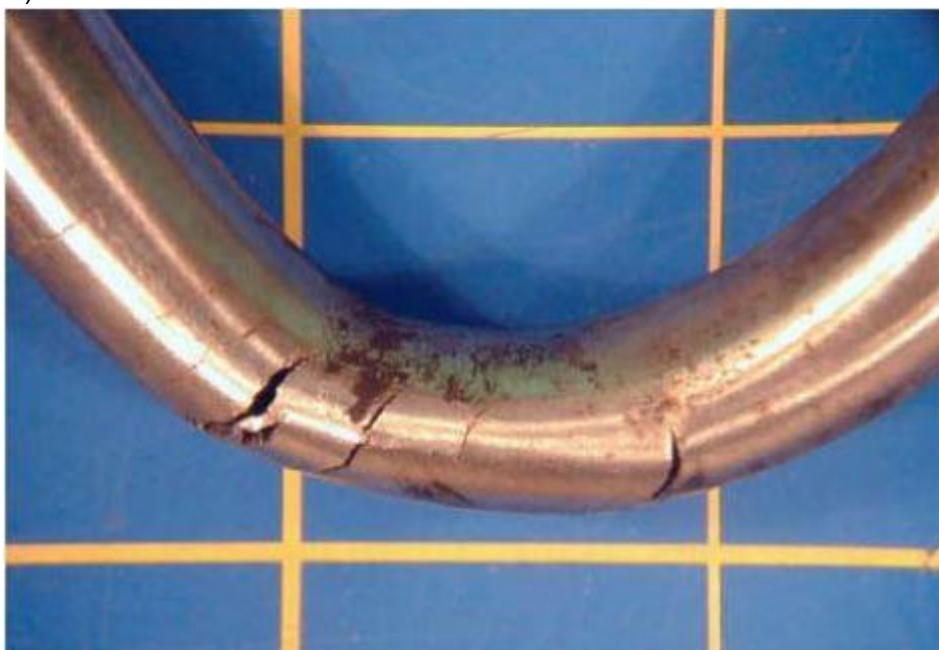
Kuva 11 Ulkopuolista säröilyä ja halkeilua eristeidenalaisessa 304SS-tyypin teräsputkessa (API RP 571 2011, 4-187.)
