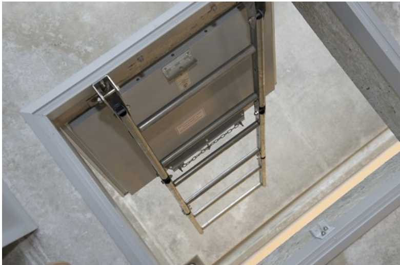
Kuva 17. Varatie parvekelaatan läpi (20)
