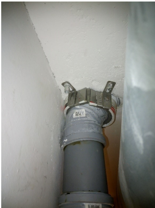
Kuva 11. Viemäriputken suojaus palokatkomansetilla
