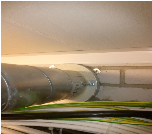
Kuva 15. Palopelti osastoivan rakenteen läpiviennissä
