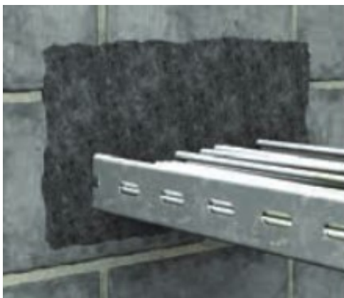
Kuva 8. Laajenevalla palokatkomassalla täytetty kaapelihyllyn läpivienti (8)
