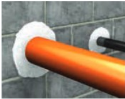
Kuva 6. Metalliputkien läpivientien tiivistys (8)
