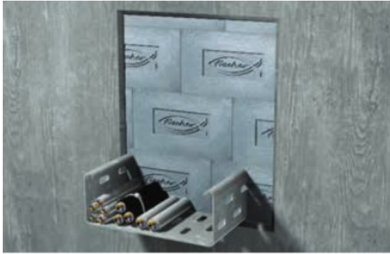
Kuva 9. Seinäläpiviennin paikkaus palokatkoililla (8)
