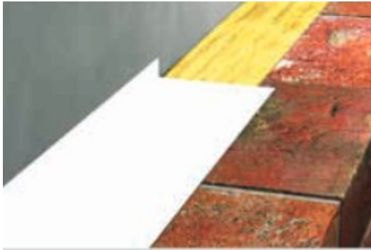
Kuva 7. Palokatko pinnoite lineaarisessa rakennesaumassa (8)
