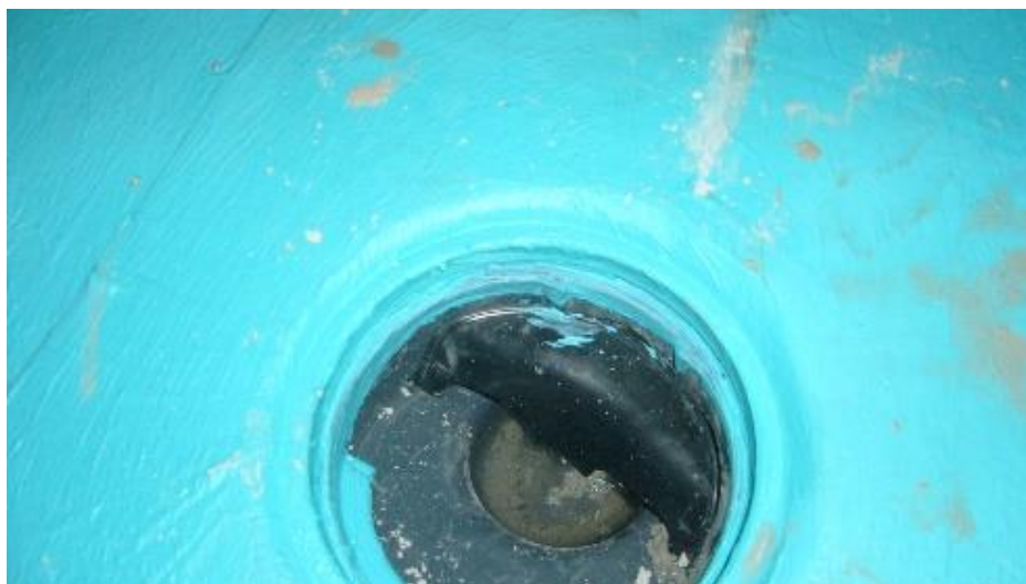
Kuva 11. Kaivon tarkastus. (Valtanen 2016)
