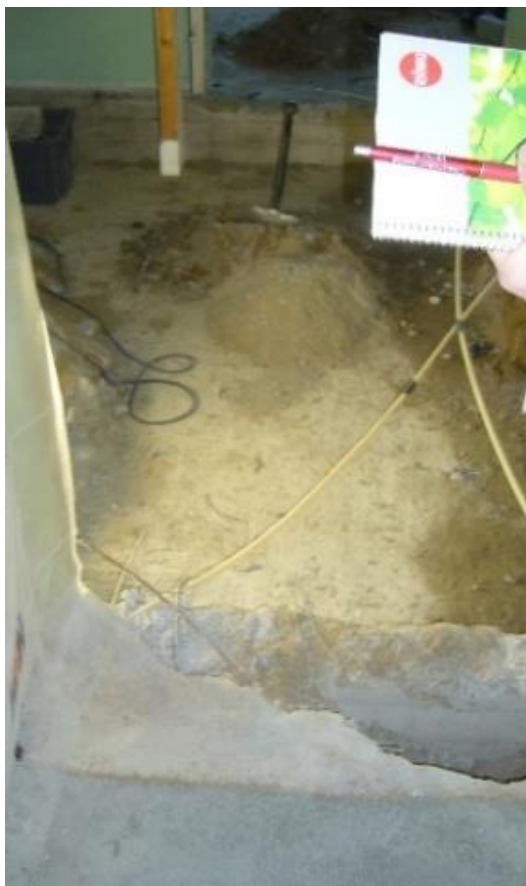
Kuva 1. Eteisen purku (Valtanen 2016)
