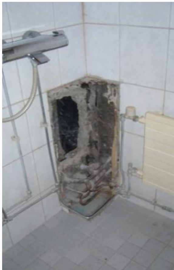
Kuva 2. Hormin purku (Valtanen 2016)
