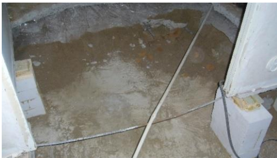
Kuva 3. Makuuhuoneen purku (Valtanen 2016)
