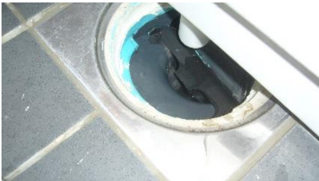
Kuva 14. Lattiakaivo valmis liittymä ja laatoitukset laatu (Valtanen2016)
