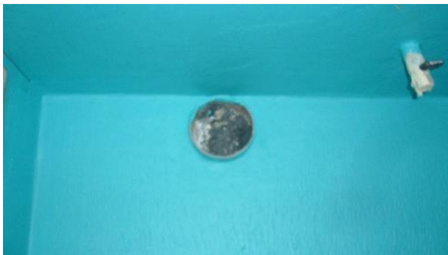
Kuva 10. Lattian vedeneristys ja läpiviennin tarkastus/mittaus. (Valtanen 2016)
