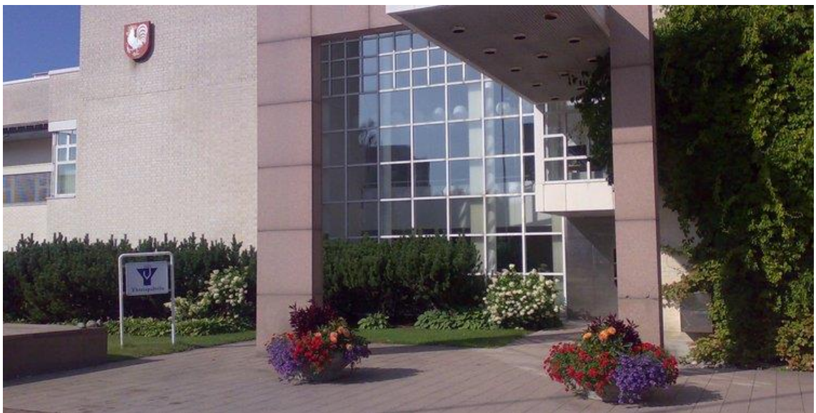
Kuva 1 Laitilan kaupungintalo Keskuskadulla
