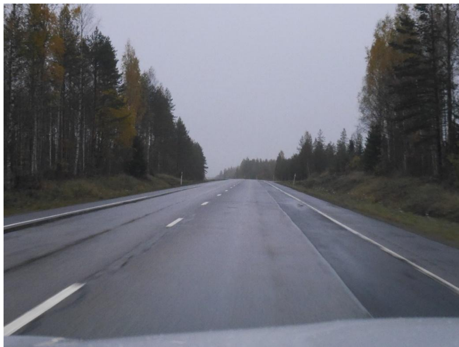
Kuva 6. Yksiajoratainen (1+1) päätie leveällä päällystetyllä pientareella, jossa vastakkaiset ajosuunnat on erotettu keskiviivalla, Vt 4 Rantsila (Lepistö 2016).
