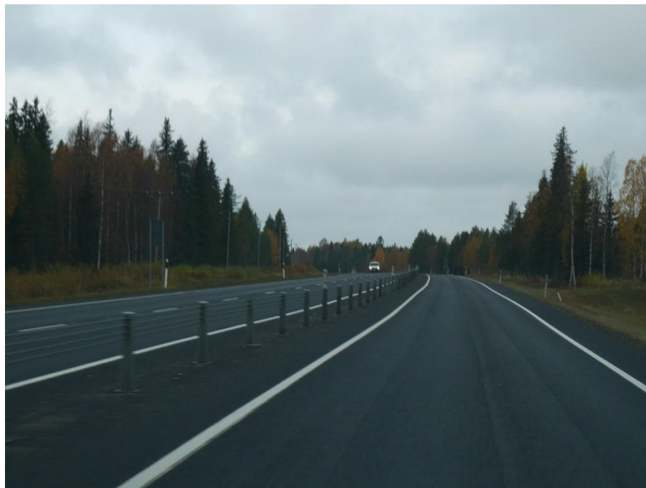
Kuva 10. Ohituskaistatie keskikaiteella, vaijerikaide (1+2 ajokaistaa), Vt 4 Simo (Lepistö 2016).
