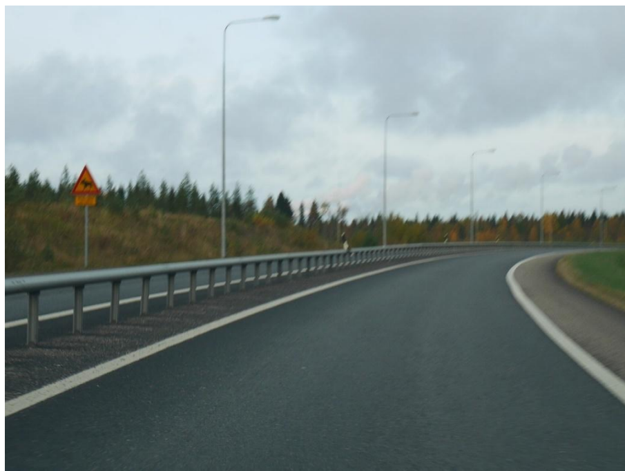
Kuva 18. Moottoriliikennetie, jonka vastakkaiset ajosuunnat on erotettu toisistaan kaiteella, Vt 4 Kemi (Lepistö 2016).
