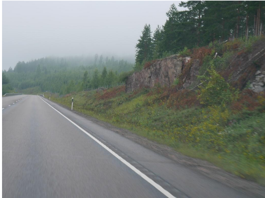
Kuva 27. Leveä leikkaus ja korkea vastaluiska, Vt 9 Länkipohja (Lepistö 2016)
