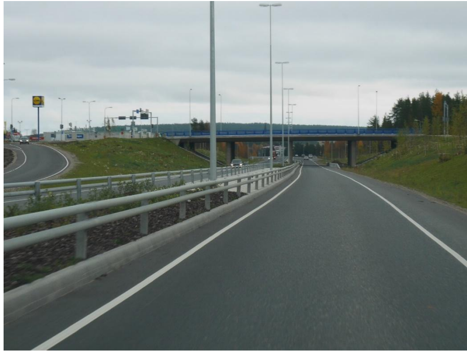
Kuva 8. Yksiajoratainen (1+2) päätie, jossa vastakkaiset ajosuunnat erotettu keskisaarekkeella ja -kaiteella, Vt 4 Rovaniemi (Lepistö 2016).
