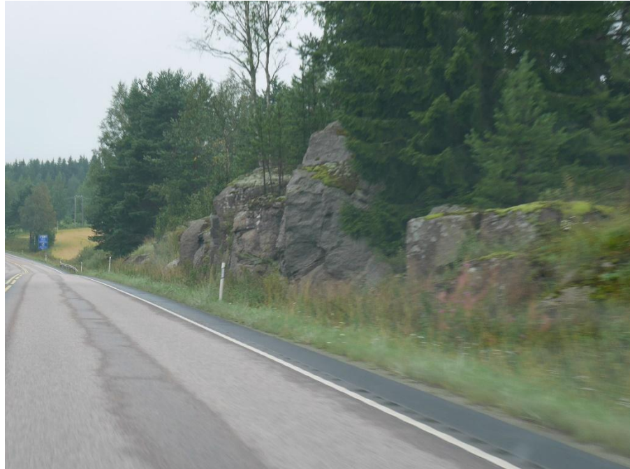
Kuva 26. Kallioleikkaus ilman suojakaidetta, Vt 9 Jämsä (Lepistö 2016)
