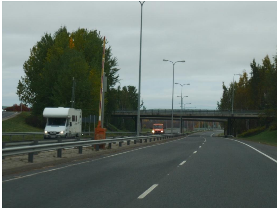
Kuva 17. Kaksiajoratainen päätie keskikaiteella, Vt 4 Rovaniemi (Lepistö 2016).
