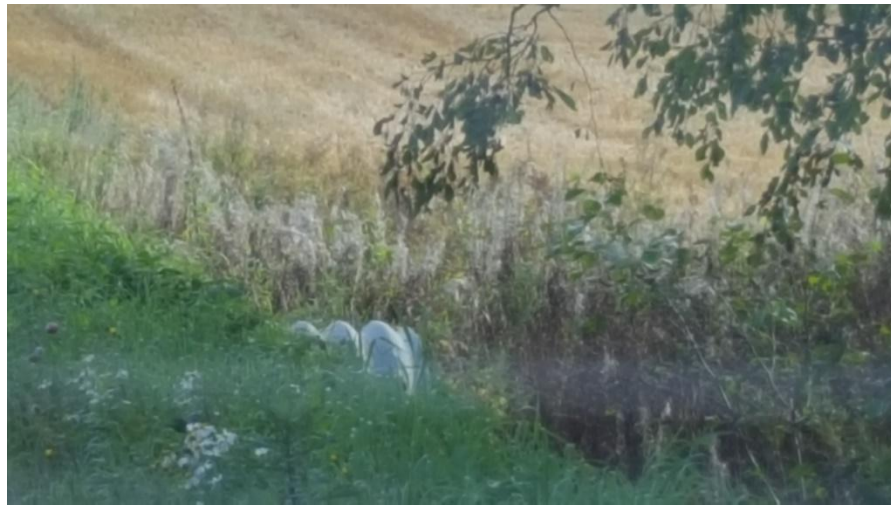
Kuva 29. Rummunpää luiskassa, St 322 Pälkäne (Lepistö 2016)
