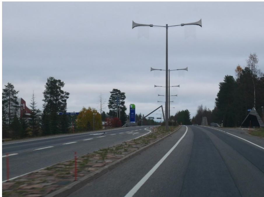
Kuva 9. Yksiajoratainen päätie, jossa vastakkaiset ajosuunnat erotettu toisistaan keskisaarekkeella liittymäkanavointien takia, Vt 4 Rovaniemi (Lepistö 2016).
