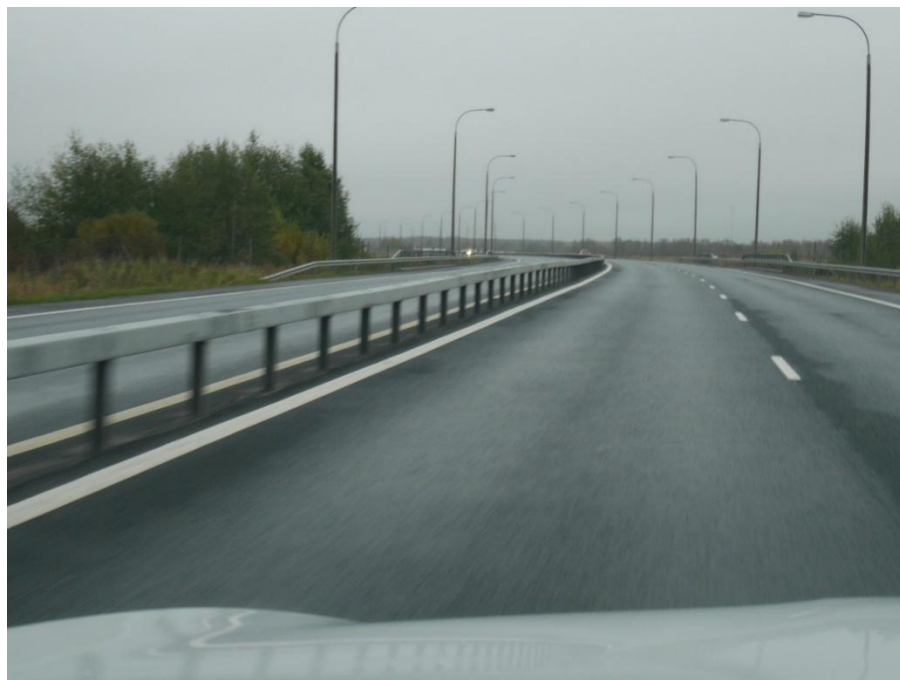
Kuva 14. Moottoritie kapealla keskikaistalla, vastakkaiset ajosuunnat erotettu keskikaiteella, Vt 4 Oulu (Lepistö 2016).
