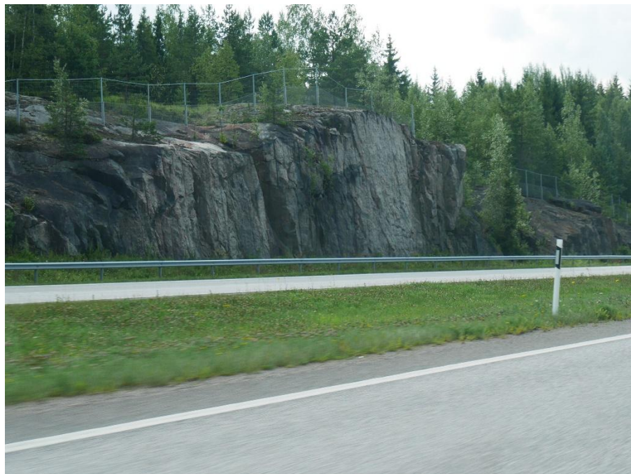
Kuva 23. Kaiteella suojattu moottoritien kallioleikkaus, Vt 3, Nurmijärvi (Lepistö 2016)
