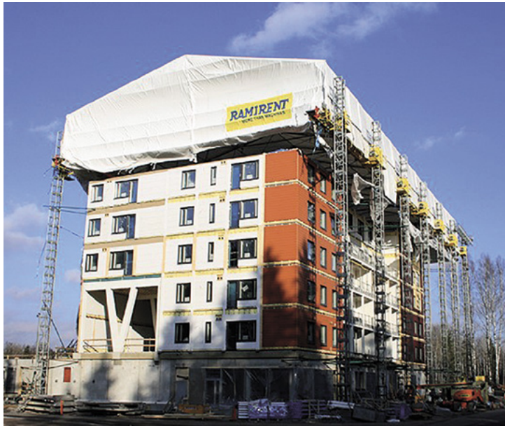
Kuva 16. Sääsuojaus (Ramirent Finland Oy 2017)
