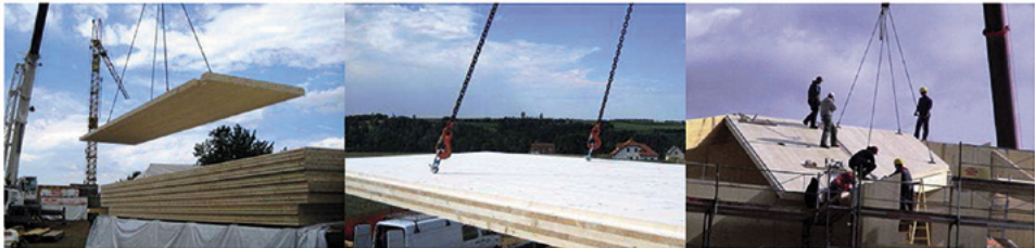
Kuva 5. Väli- ja yläpohjalevyjen nostot (Stora Enso 2013)
