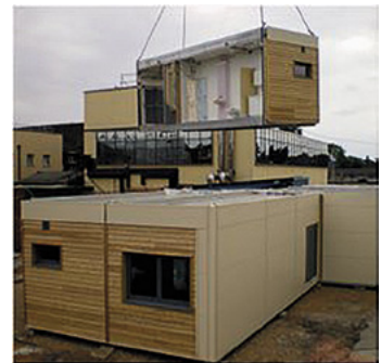
Kuva 7. CLT-tilaelementti rakentaminen (Pinterest 2016)
