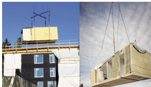
Kuva 6. Tilaelementtien nostaminen. (Puuinfo 2017)
