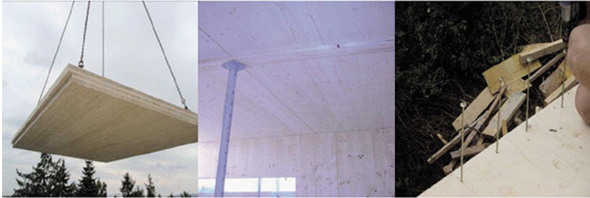
Kuva 13. Välipohjaelementin asennus (Stora Enso 2013)
