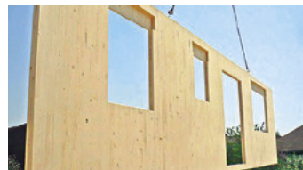
Kuva 5. CLT-pienezlementti (Jalokivitalo 2016)
