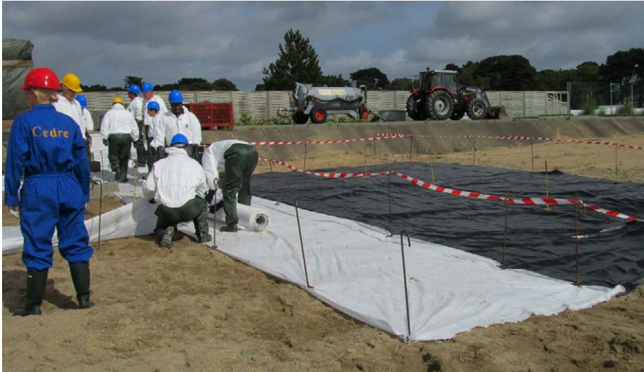
KUVA 2. Keräystyömaan perustaminen käynnissä (kuva Melinda Pascale 2010).
