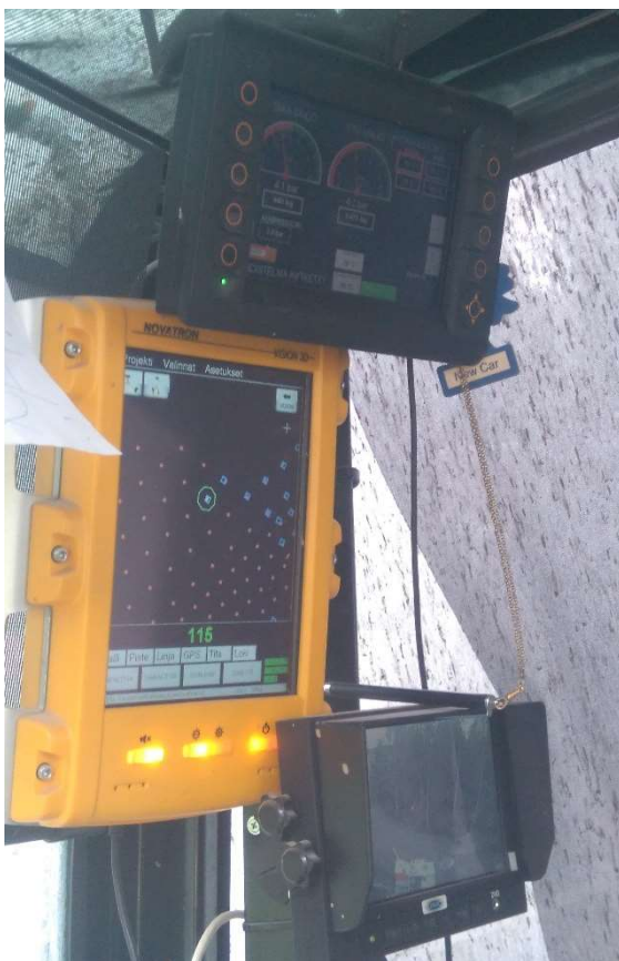
Kuva 9. Pilaristabilointikoneen GPS, jossa näkyy työkuva.
