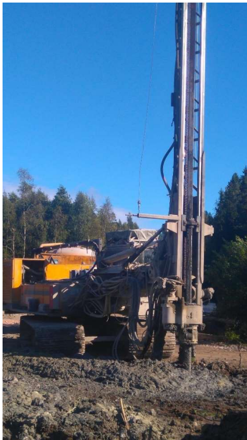
Kuva 11. Pilaristabilointikoneen kaira on maan sisällä.
