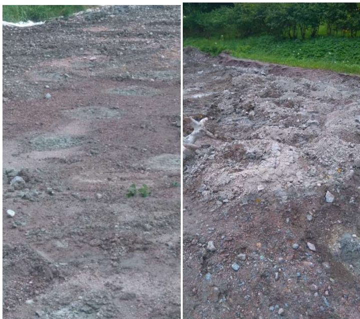
Kuva 6. Valmis pilaristabilointi, kenttä.
