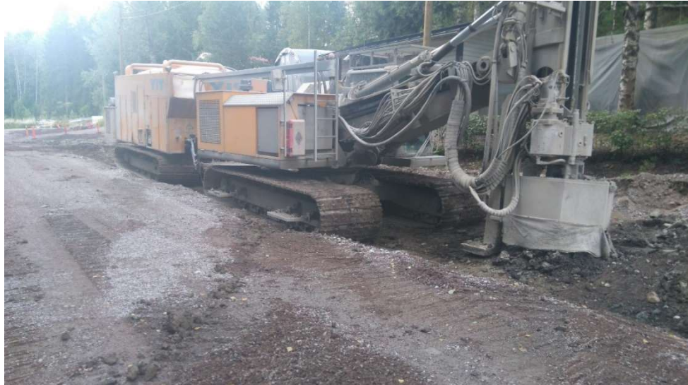
Kuva 4. YIT Rakennus Oy:n pilaristabilointikone.
