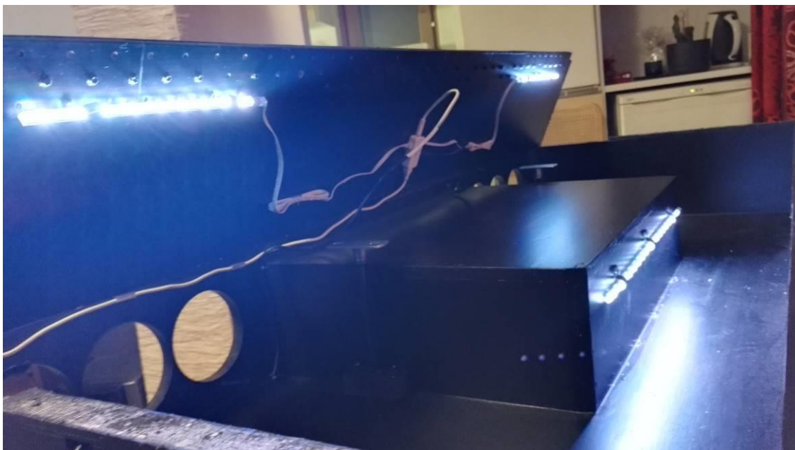
Kuva 14. Pöydän sisäpuolisen valaistuksen asennus käynnissä.
