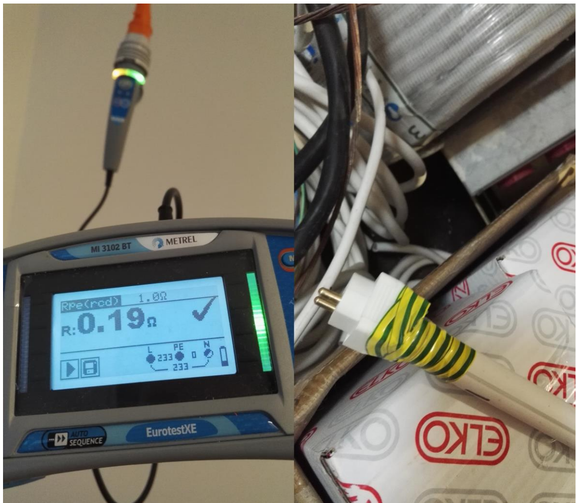
Kuva 6. Kuva omatekemästä mittakepistä, jolla pystyttiin mittaamaan kohteen valaisinpistorasioista suojajohdon jatkuvuudet kätevästi.
