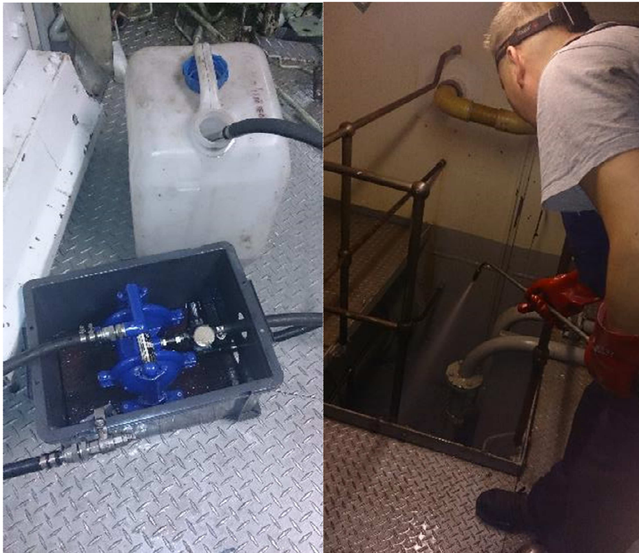
Kuva 21. Kalvopumppu ja liuottimen levitystä.
