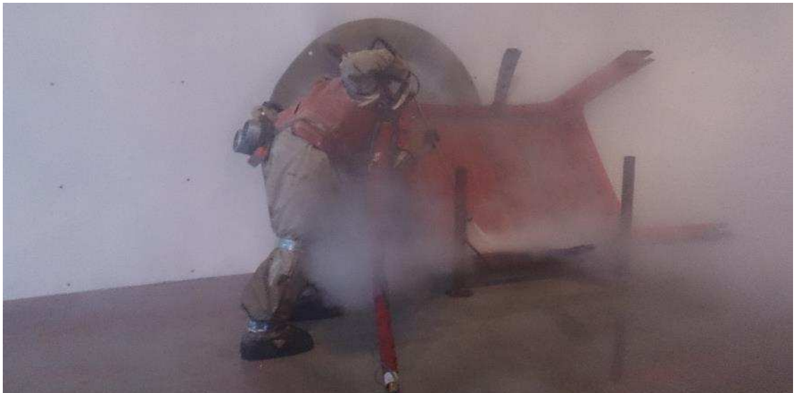
Kuva 16. Vesisumun muodostumista 3000 baarin ultrakorkeapainelaitteella pestessä.
