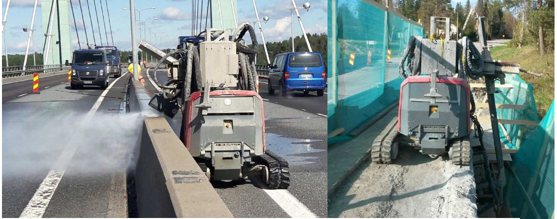
Kuva 15. Pesurobotti piikkaamassa betonia (Tönisson 2016)
