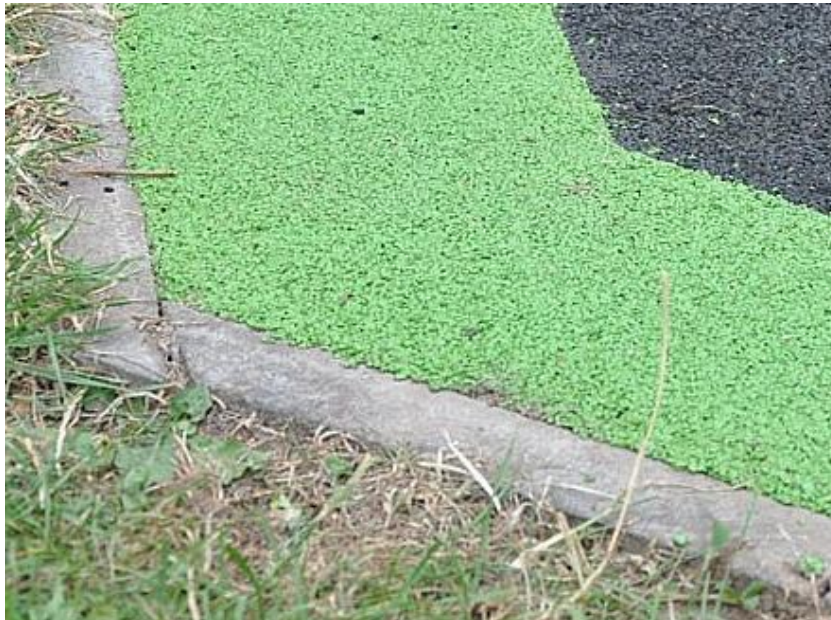
Kuva 3. Tyypillinen betonireunus (RTC n.d.).
