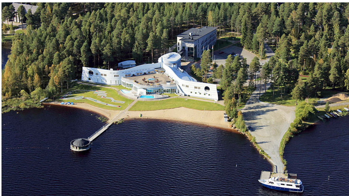
KUVA 1. Kylpylähotelli ilmasta kuvattuna (Break Sokos Hotel Bomba s.a.)
