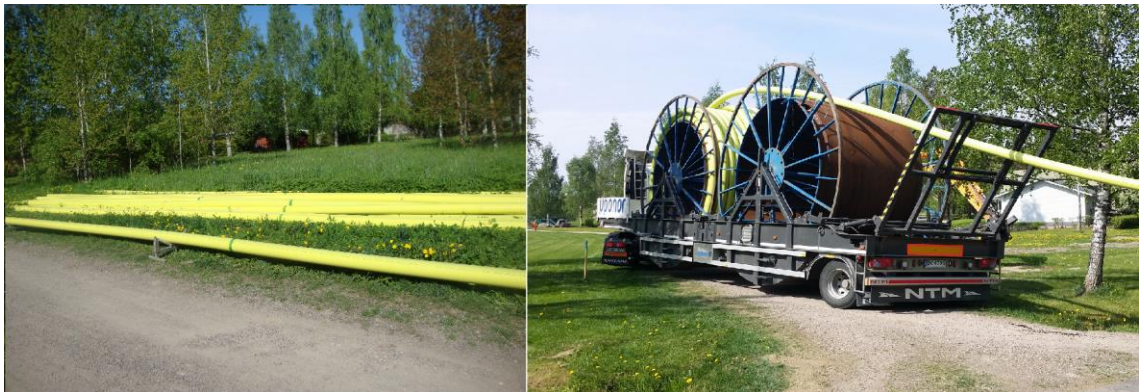
Kuva 4. 160 mm:n profuse -kaasuputki. Vasemmalla kuvassa kankiputkien sijoittaminen työmaalle hitsausta varten ja oikealla kelaputken purkaminen kelalta.
