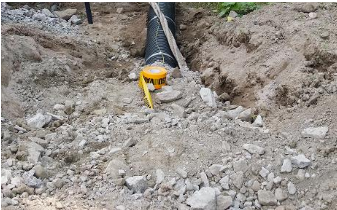
Kuva 14. Kaasuvaroitussauhan asentaminen suojaputken päälle.
