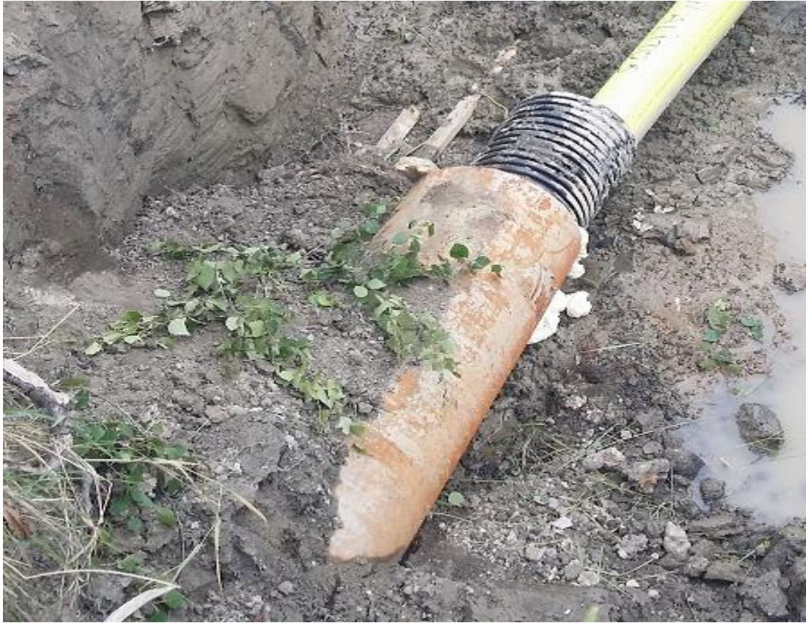
Kuva 5. Kuvassa junaradan alitukseen käytettävät metallinen ja muovinen suojaputki, jonka sisältä tulee keltainen 160 mm:n profuse-kaasuputki.
