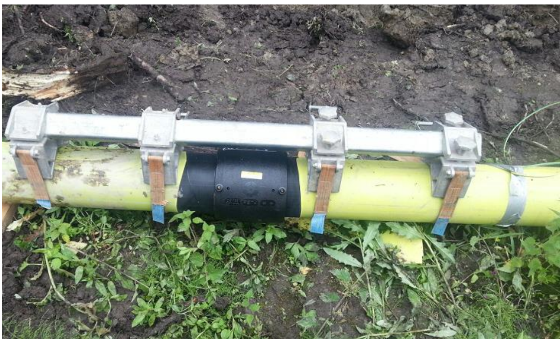
Kuva 12. Hitsaustuki estämässä putkien liikkumisen.
