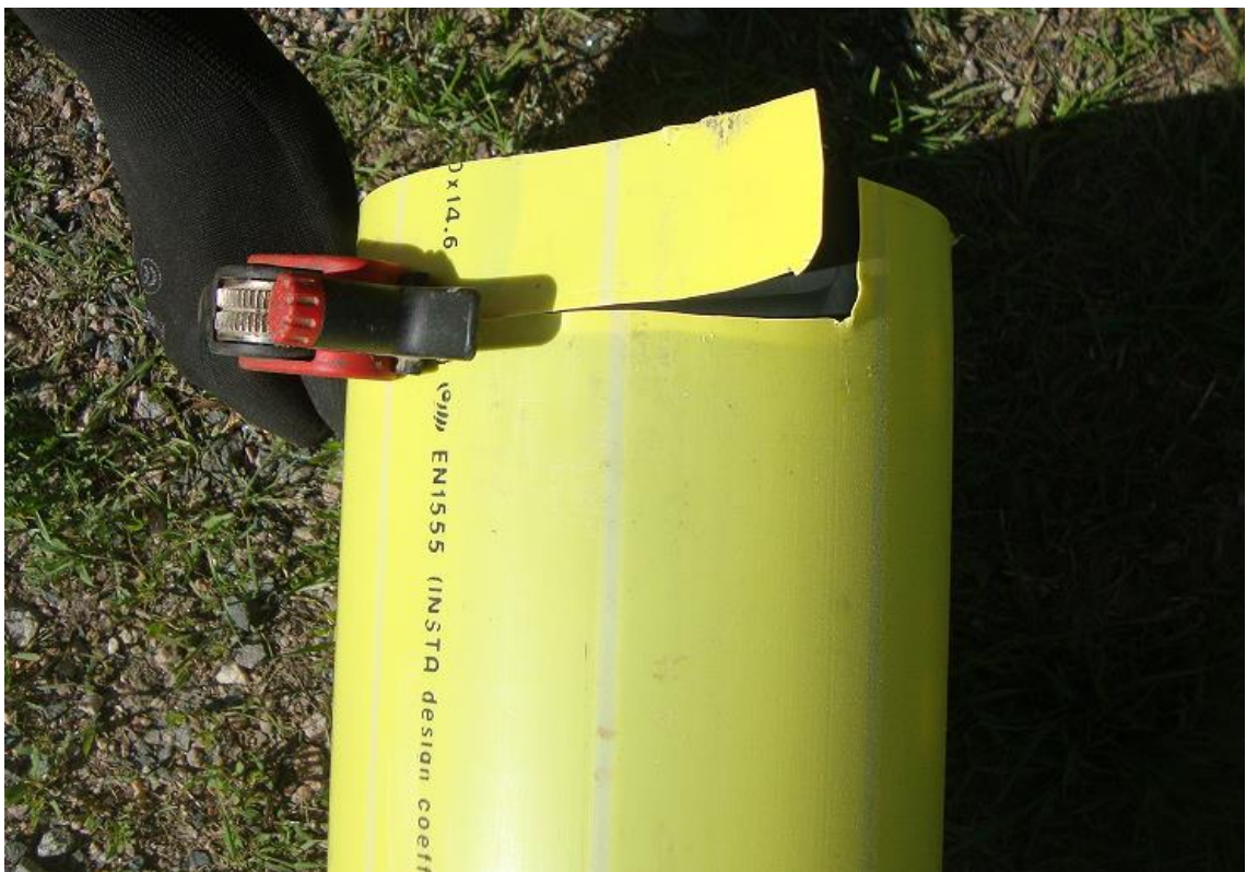
Kuva 8. Putken suojakuoren poistaminen.
