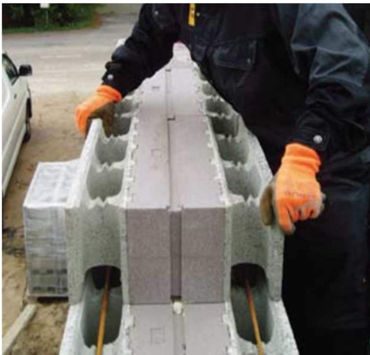
Kuva 8. Eristetyn valuharkon ladonta (Harkkokäsikirja 2016 Kevytsoraharkot ja betoniharkot.)
