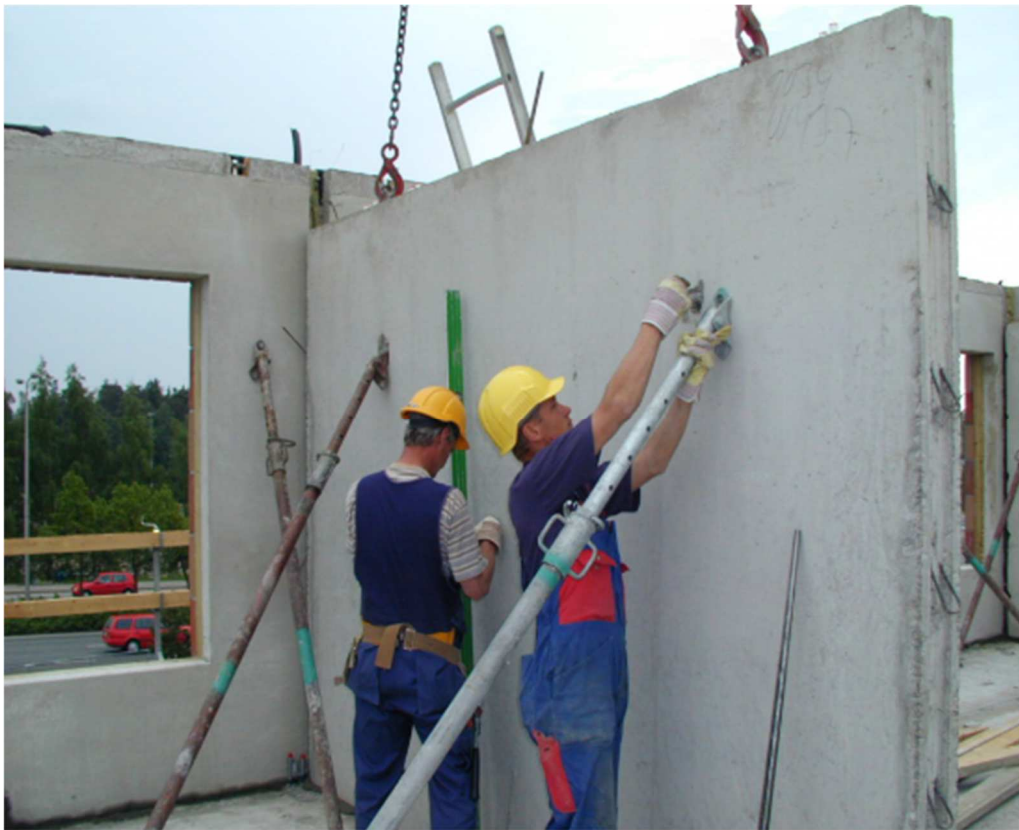
Kuva 2. Seinäelementin tuenta (Betonielementtien turvallinen asennus.)
