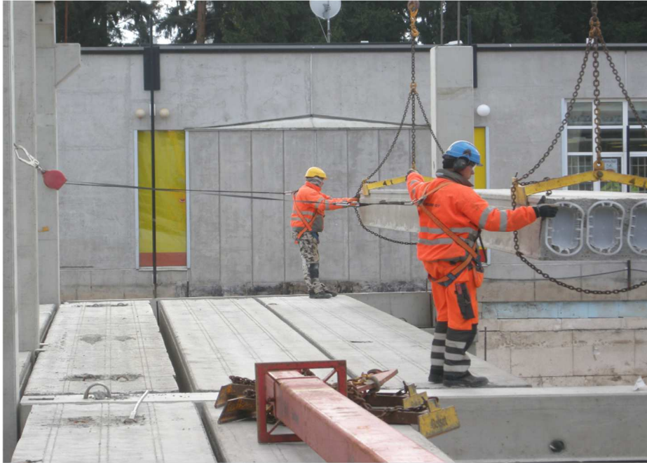
Kuva 4. Ontelolaatan asennus (Betonielementtien turvallinen asennus.)
