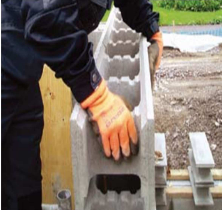
Kuva 7. Valuharkon ladonta (Harkkokäsikirja 2016 Kevytsoraharkot ja betoniharkot.)
