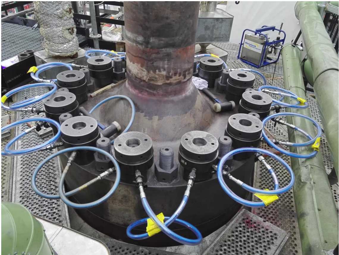
Kuva 5. Porvoon jalostamon tuotantolinjan 4 LCF-reaktori 1:n kansiruuvit asennetaan hydraulista vetotyökalua käyttäen. Taka-alalla näkyvällä ohjauspöydällä pumpataan hydraulioiljyä ruuvien kierteisiin asennettuihin sylintereihin, jotka paineen vaikutuksesta aiheuttavat ruuviin vetävän voiman. Kuvassa Tentecin valmistama työkalu.
