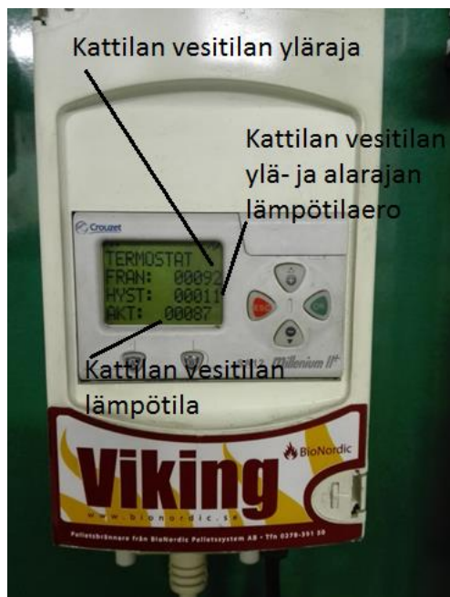
Kuva 21 Pellettipolttimen ylä- ja alarajat (Iiska Kaukola-Risku, 2016)
