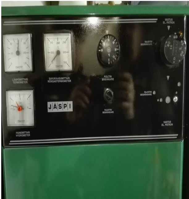
Kuva 22 Kattilan (Jäspi) kiinteät mittalaitteet (Iiska Kaukola-Risku, 2016)
