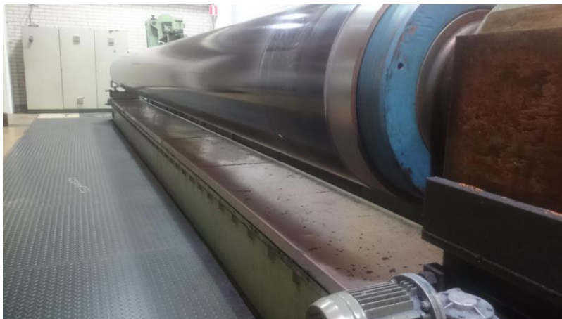
Kuva 7. Pyörivään telaan on esteetön pääsy.
