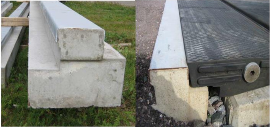
KUVA 5. Kumisen tasoristeysrakenteen siirtymäpalkki (Liikennevirasto 2004)
