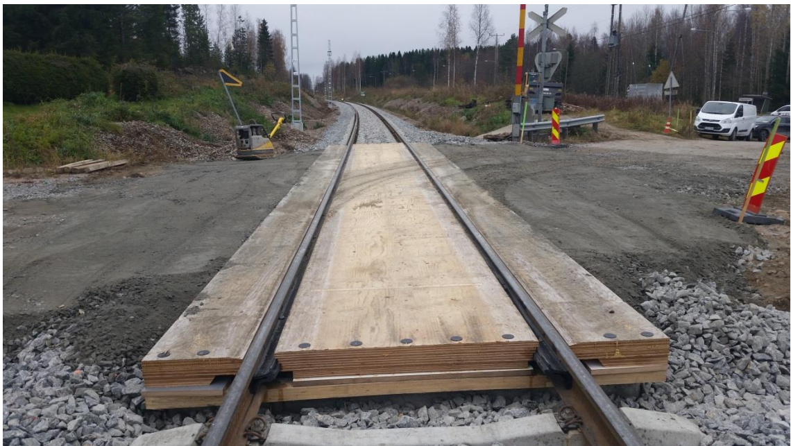
KUVA 4. Läpimenevä ankkurointipuu ja uusi kansirakenne Äly-hankkeen tasoristeyksessä
