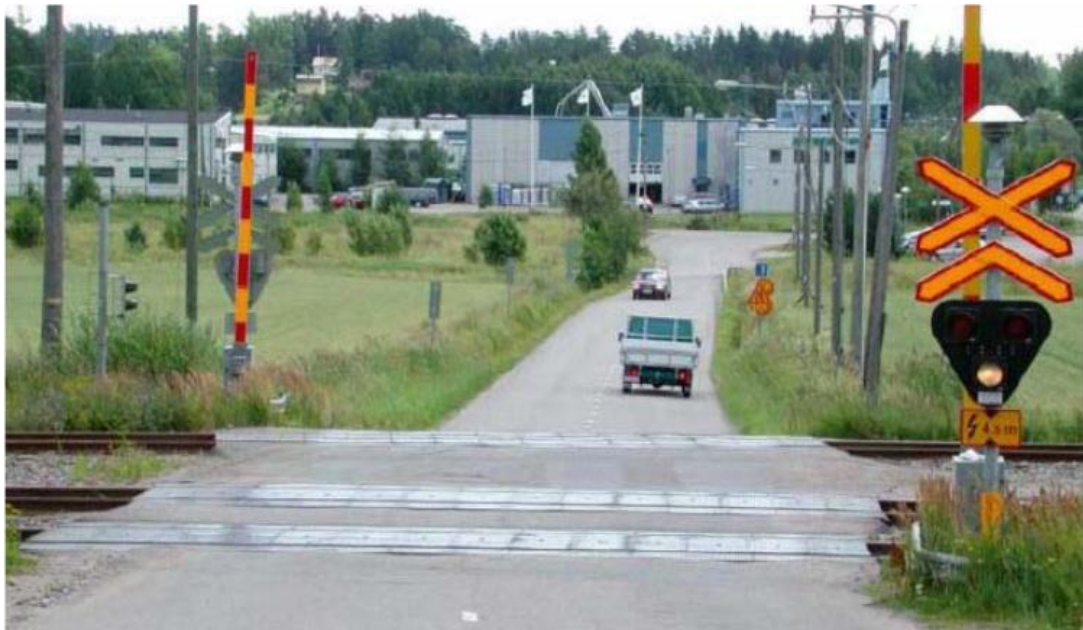
KUVA 5. Puolipuumilaitos (Liikennevirasto 2012c)
