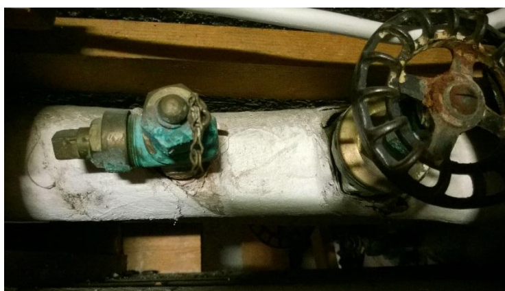
KUVA 1. Putken päällä asbestia sisältävä eristekerros (Tick 2016-06-20.)
