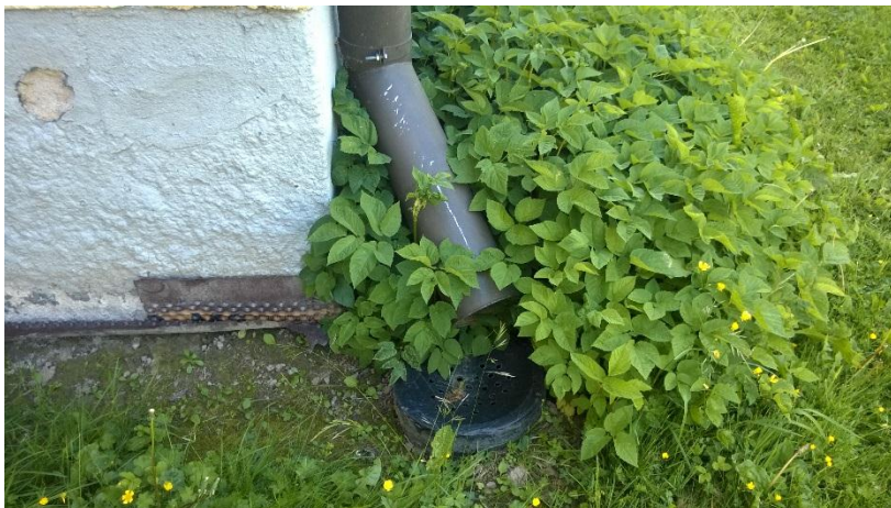
KUVA 11. Sokkelilevy ja sadevesikaivo syöksytorven alla (Tick 2016-06-20.)
