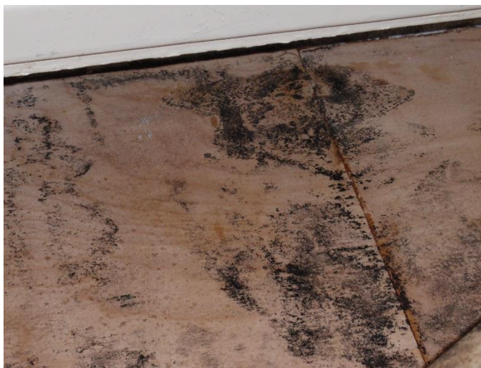
KUVA 2. Mustaa homekasvustoa vanerin pinnassa (Tick 2016-07-18.)
