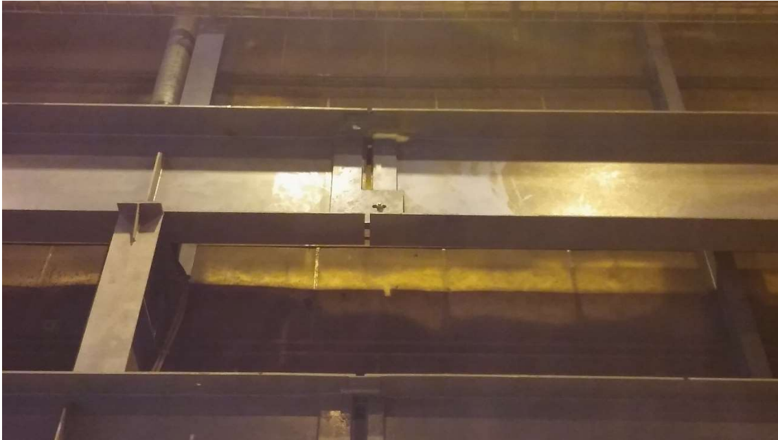
KUVA 9. Ratapalkin liikuntasauamassa I-profiilin laipat ja uuma katkaistu samasta kohdasta.
