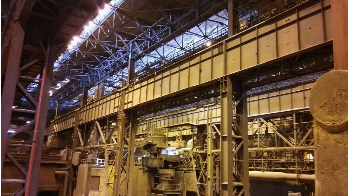
KUVA 10. Hitsatut nosturiratapalkit.
