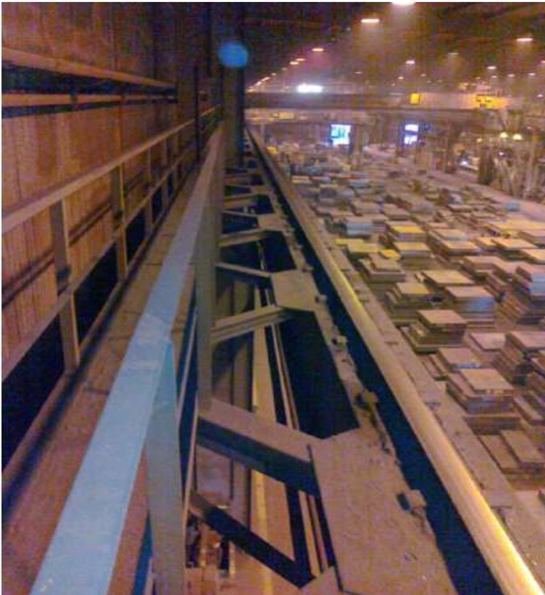
KUVA 18. Nosturiratapalkin vieressä oleva hoitotaso (SSAB dokumentti nro 4730639, 1).
