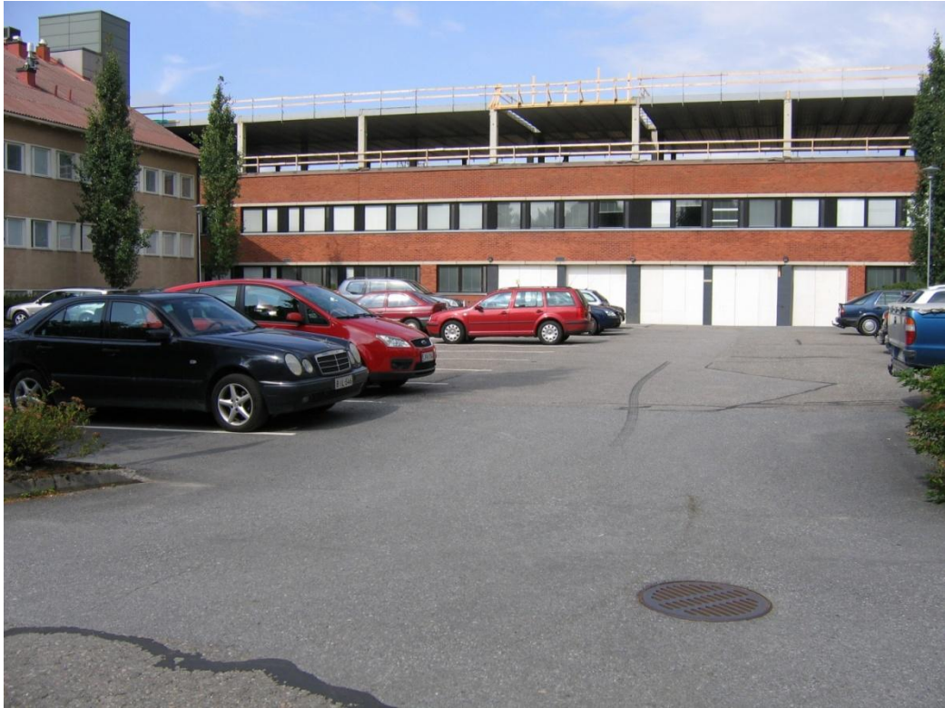
KUVA6: Rakenteilla oleva X-siipi
