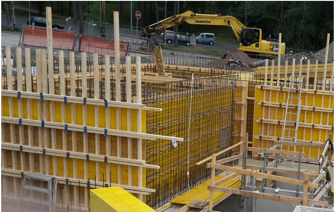
Kuva 1. Väestönsuojan laudoitus ja rauditus
