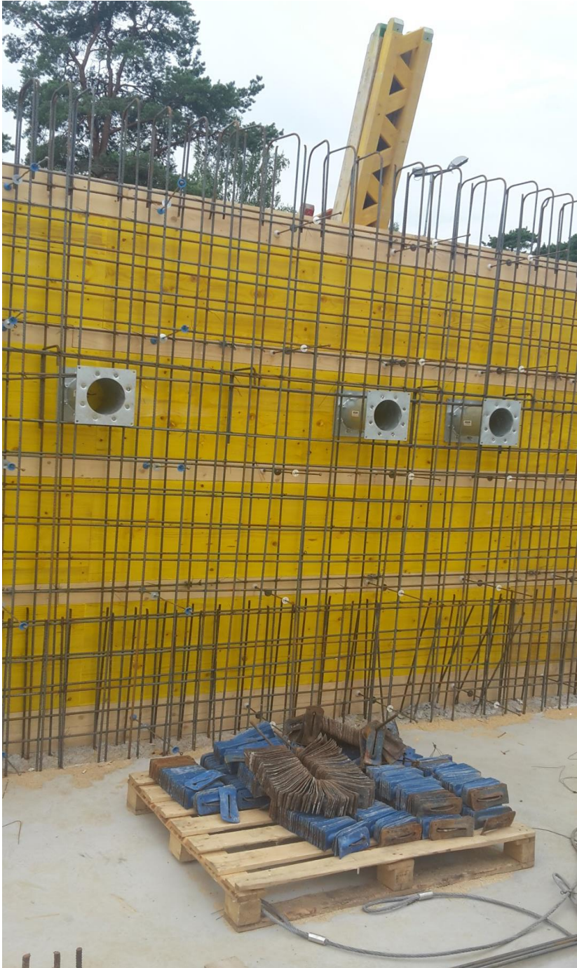
Kuva 2. Raudoitus ja valuosat
