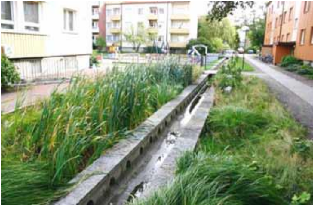
Kuva 21. Hulevesikanava korttelin sisällä (Suunnittelukeskus Oy 2007, 27)
