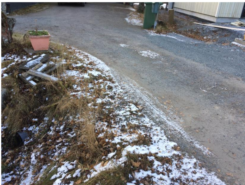
Kuva 41. Usvatien päässä kadun alta hulevedet eteenpäin johtava rumpu
