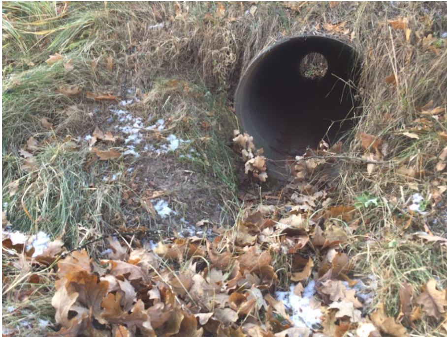
Kuva 50. Hyvässä kunnossa oleva Kinostien alittava rumpu
