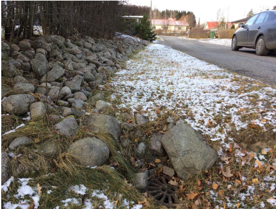
Kuva 54. Ritiläkansikaivo Lumitiellä
