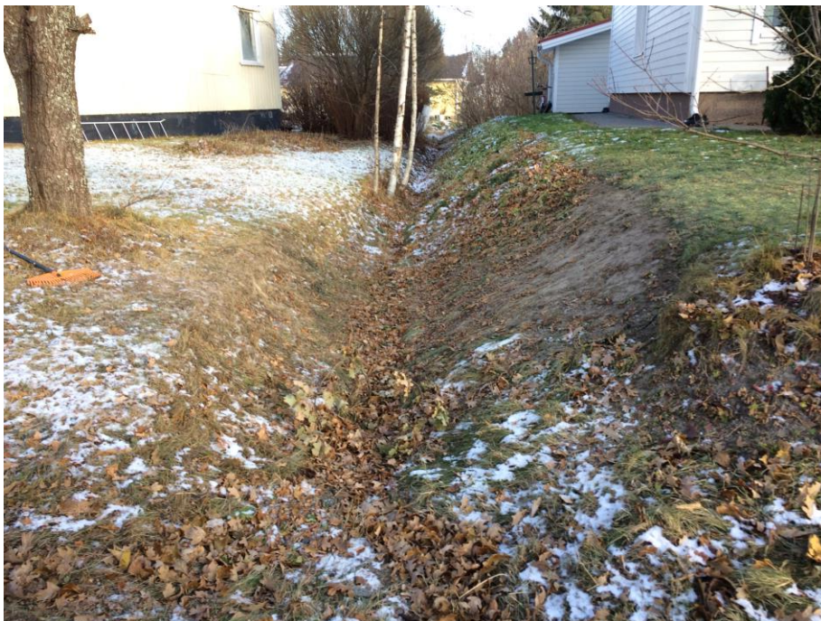
Kuva 51. Asuinrakennusten välistä kulkeva hulevedet eteenpäin johtava avo-oja
