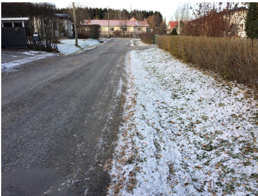
Kuva 55. Lumitien alkupään viherpainanne ennen sadevesikaivoja
