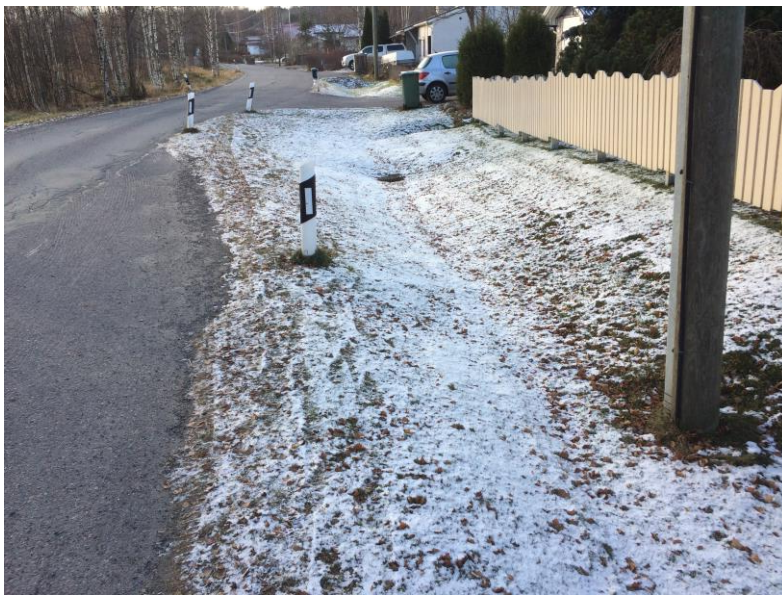
Kuva 30. Viherpainanne ja ritiläkansikaivo Vihattulantiellä
