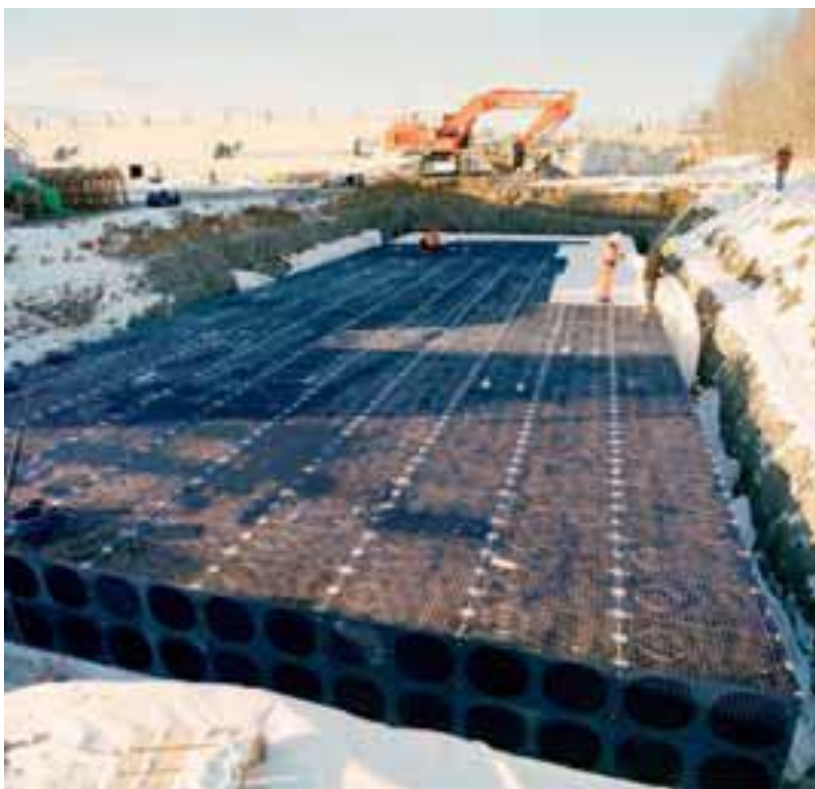
Kuva 16. Maanalainen imeytys- ja viivytyskaivanto (Suomen Kuntaliitto 2012, 149)
