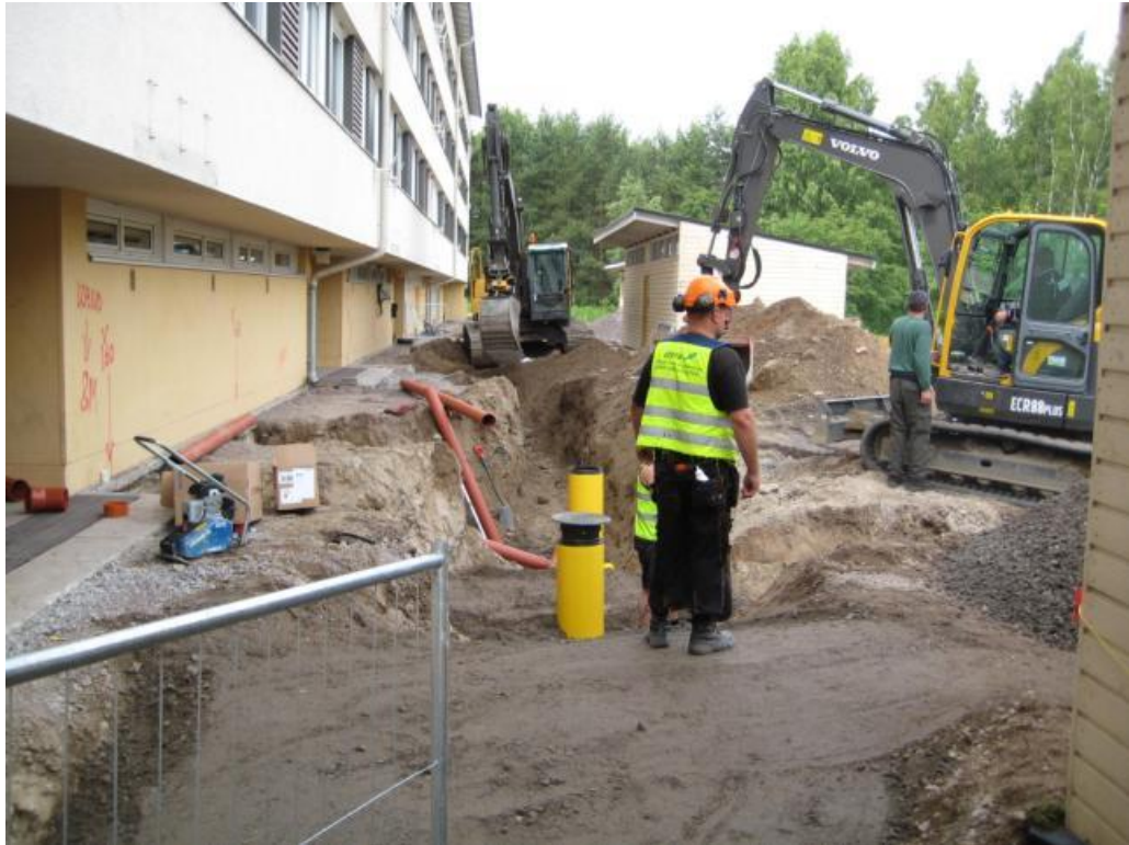
Kuva 1. Uuden jätevesiviemärin päälinjan asennus
