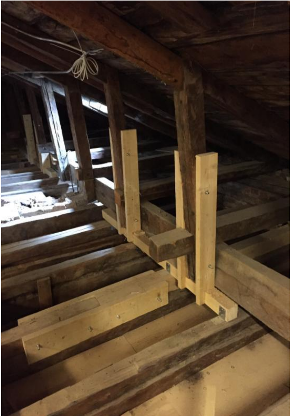
Kuva 4. Kattopalkkien uudet tukirakenteet
