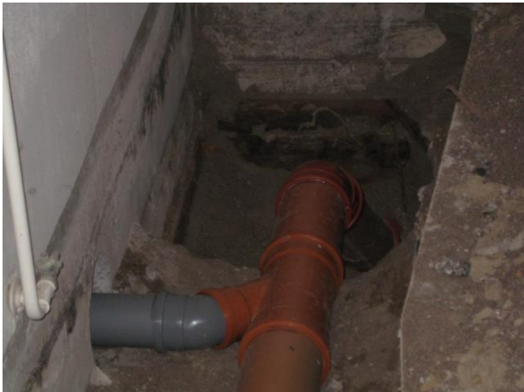
Kuva 2. Ulosjohtava uusi pohjaviemäri kellaritiloissa
