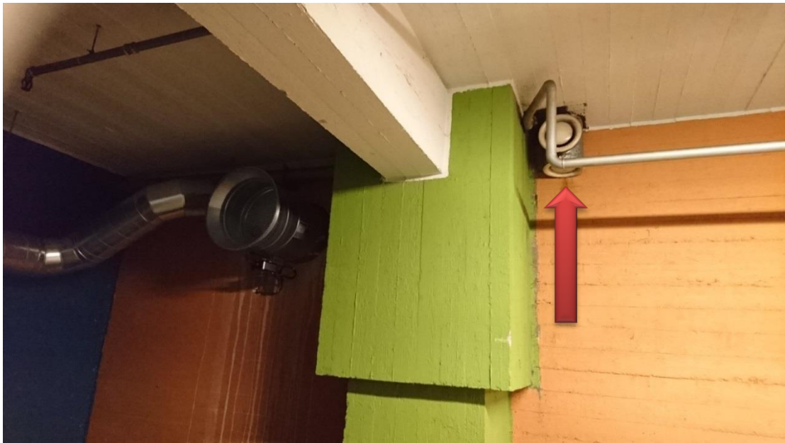
Kuva 4. Valmiiksi olemassa oleva, käytöstä poistettu putki.
