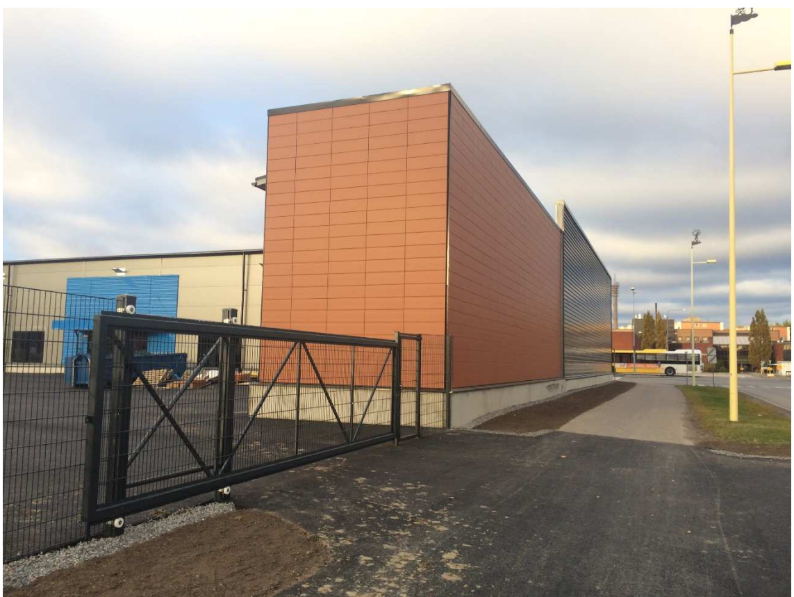
Kuva 7. Valmis tiililankku ja kasettipelti
