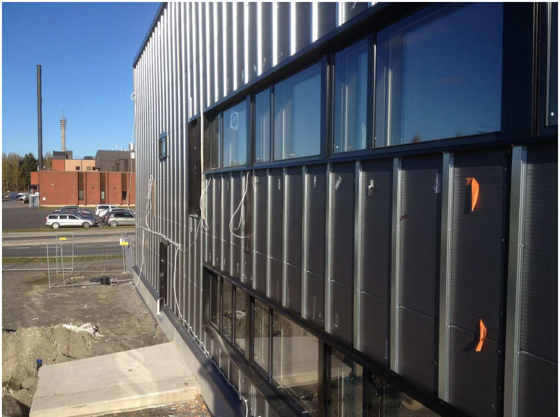
Kuva 5. Toimistopäädyn rangoitus valmis
