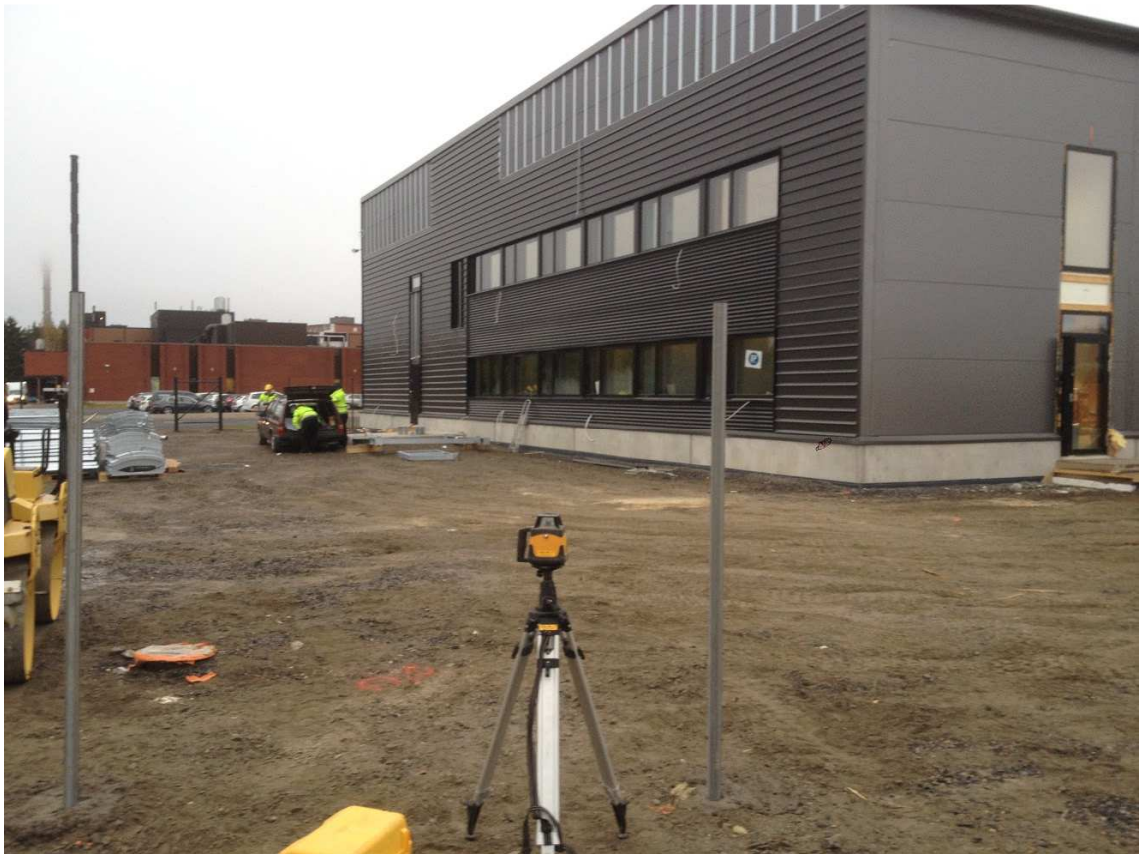
Kuva 6. Toimisto pääty pellitetty melkein valmiiksi porrassasennusta varten.
