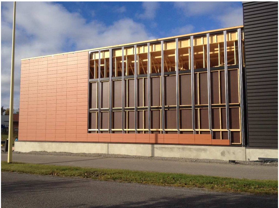
Kuva 4. varaston tiililankkujulkisivu
