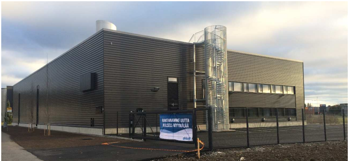
Kuva 8. Mustionkadun suunnasta valmis peltikasetti ja ikkunoiden välissä aaltopelti.
