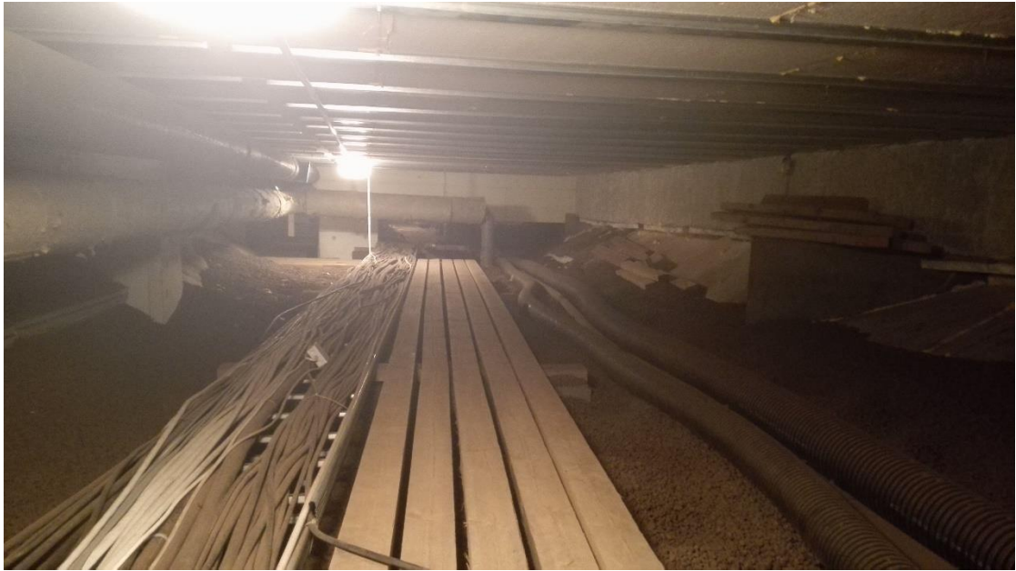
Kuva 10. Ryömintätilassa on valaistus koko matkalla ja kulkusilta asetettu keskeisesti huoltojen kannalta.
