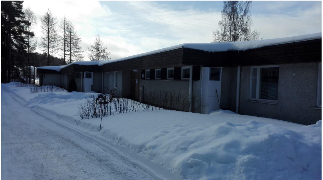
Kuva 3. L-rakennuksen ryömintätilaan kuljetaan huoltoluukusta rakennuksen etupuolelta.
