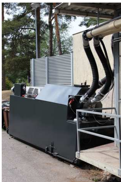
KUVA 1: alipaineistettu jätessäiliö
