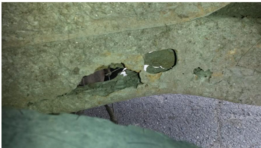
KUVA 6. Ruostevahinko rungossa takapyörän kohdalla. Jos runko on ruostunut näin pahoin, on vahinko aina esitettävä jälkitarkastuksessa. Lähde: Pekka Purosola 2015.
