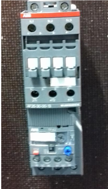
Kuva 7. ABB AF26 kontaktori sekä TF42 lämpörele.
