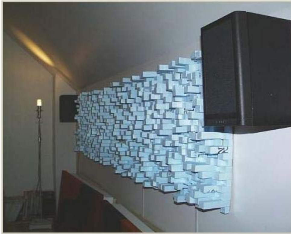
Kuva 22: Kotitekoinen diffuusori, joka materiaalinsa takia myös absorboi ääntä. (Tee-Se-Itse Tehokas Diffuusori [viitattu 05-02-2008]).
