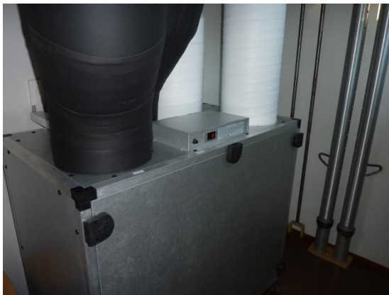
Kuva 13 Uusi ilmanvaihtokone.
