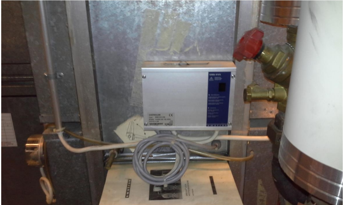
Kuva 29 TK1 LTO:n ohjainyksikkö
