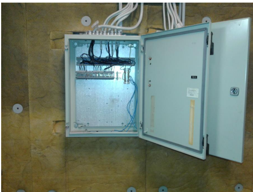
Kuva 24 Tyhjä säätölaitekotelo.
