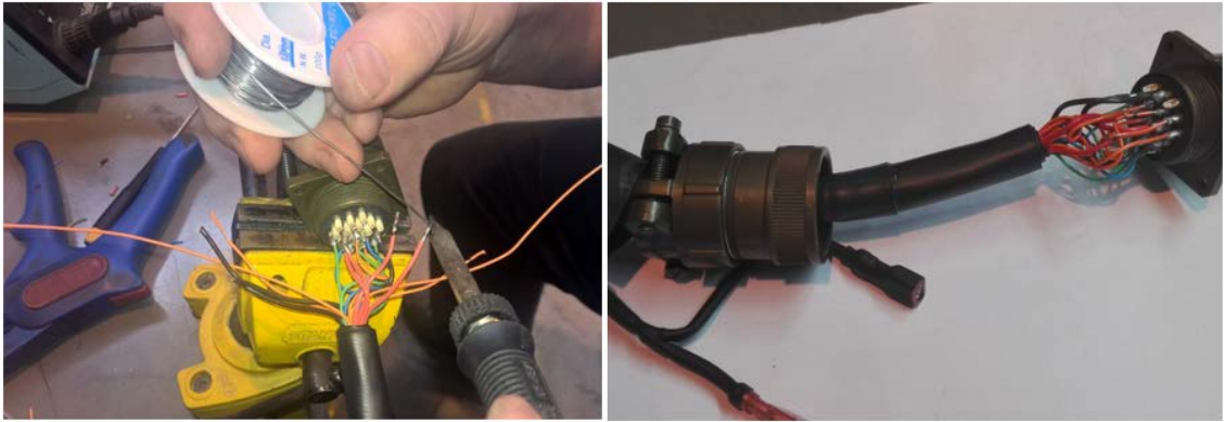
Kuva 13. Vasemmalla johdinten juottaminen MIL-liittimeen ja oikealla johtimeen ensimmäiseksi pujotetut rakenneosat sekä valmis juotos.
