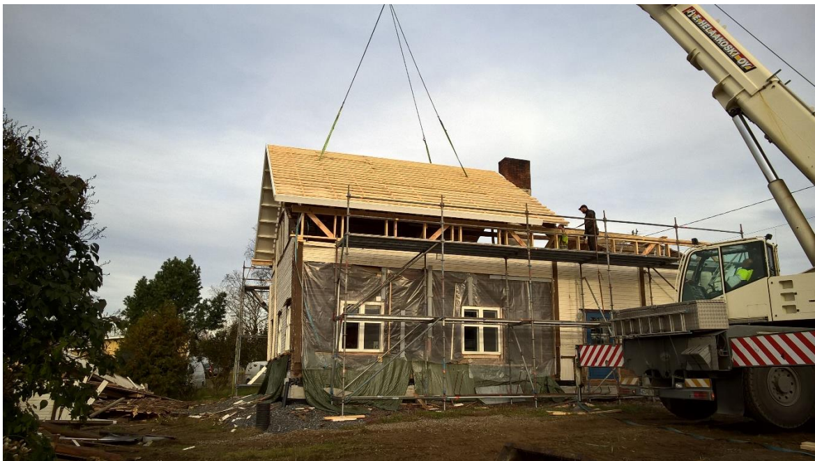
Kuva 6. Uuden katon nosto.
