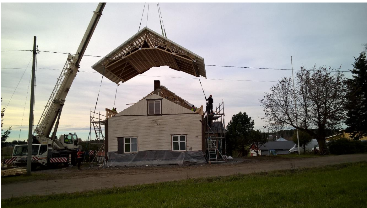
Kuva 7. Uuden katon nosto.
