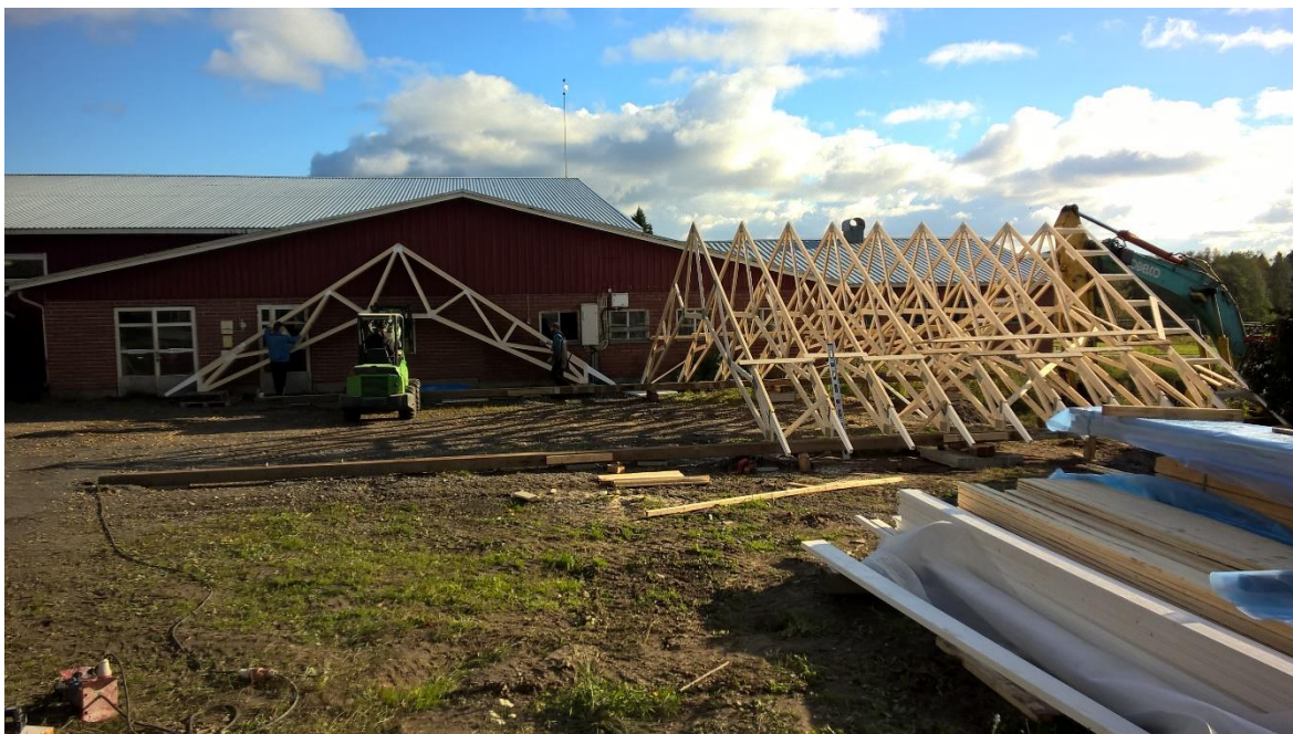
Kuva 1. Uusi vesikatto rakenteilla
