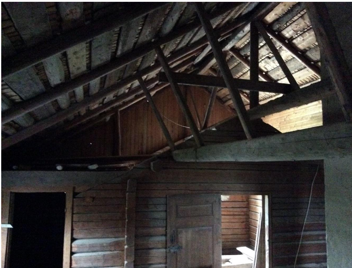
Kuva 2. Vanha vesikatto sisältäpäin.
