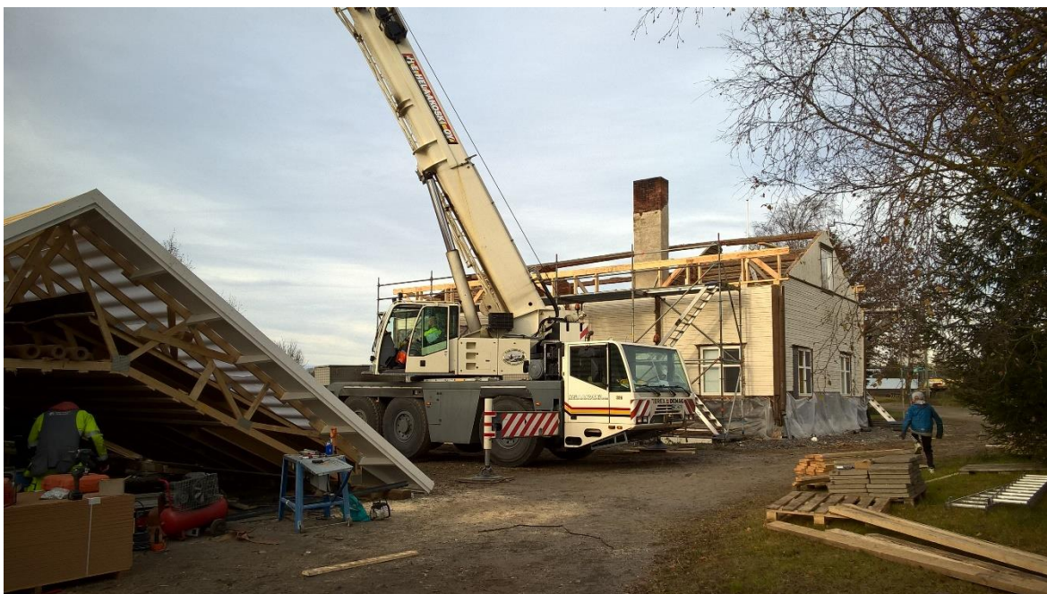
Kuva 5. Uuden katon nosto.
