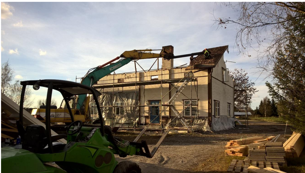
Kuva 4. Vanhan katon purku.
