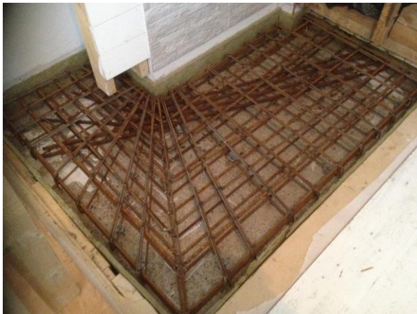
Kuva 18 Takan pohjan raudoitusta.
