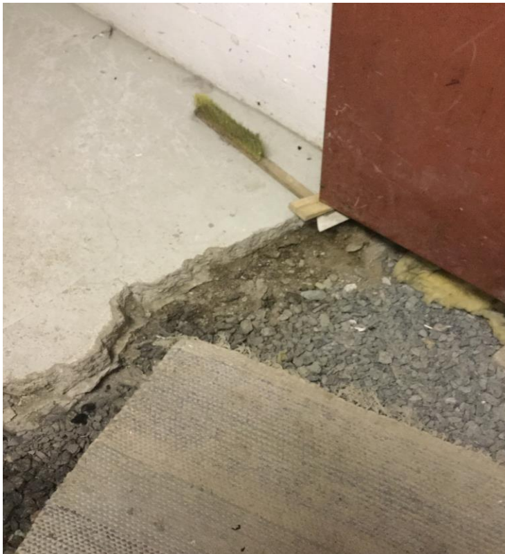
Kuva 11 Betoni-laatta osittain poistettu
