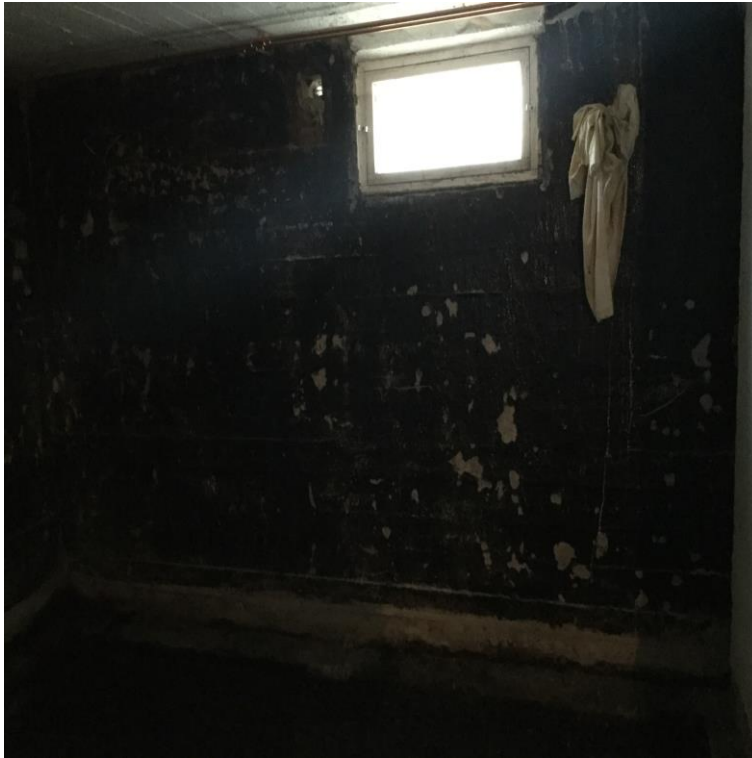
Kuva 10 Seinän sisäpuolen pikieristystä
