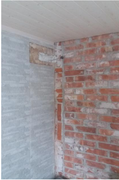
Kuva 19 Takalle muurattiin uusi palomuuuri.
