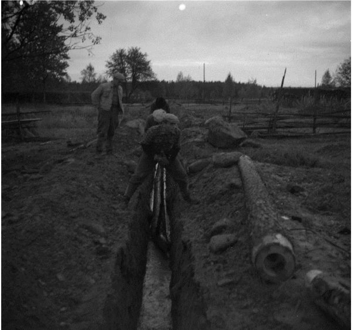
Kuva 2. Puuputkien asennusta Jurvassa 23.9.1948 (Kangas 1948.)
