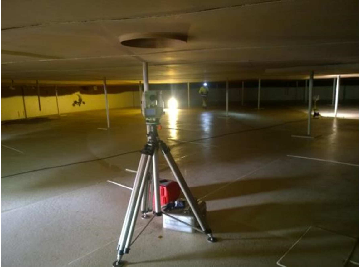
Kuva 9. Näkymä uivakattoisen säiliön pohjalta. Kuvassa näkyvät selkeästi teräksinen välikatto, tukijalat, välikaton miesluukku, pohjan levytykset sekä taustalla säiliön vaippaa.
