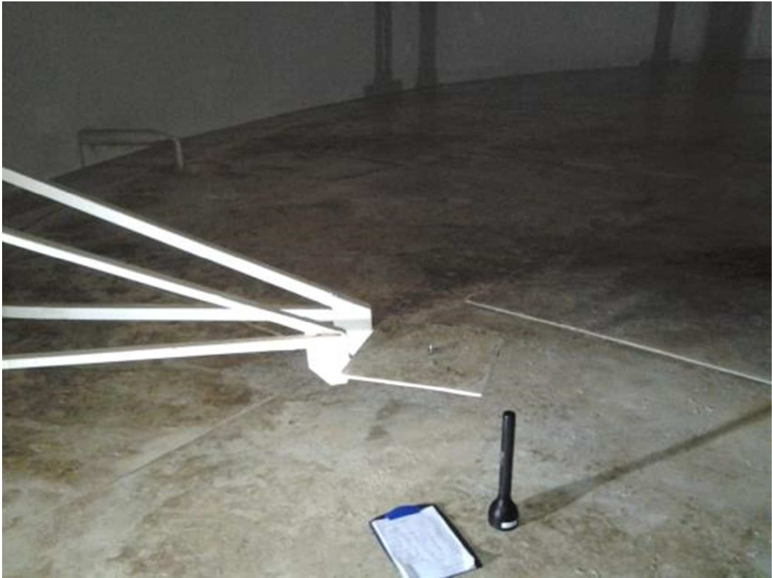
Kuva 6. Kuvassa esiintyy keskellä luotilevy sekä alapuolella hitsatut pohjalevyt ja taustalla ylöspäin kohoava vaippaosa.
