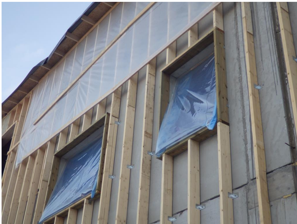
Kuva 9. Ikkuna-aukkojen osalta sääsuojaus oli toteutettu hyvin.
