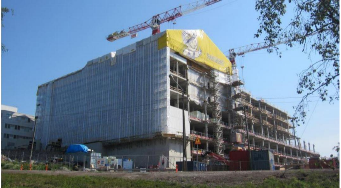
Kuva 2. Espoon sairaalan sääsuojaus. [14.]
